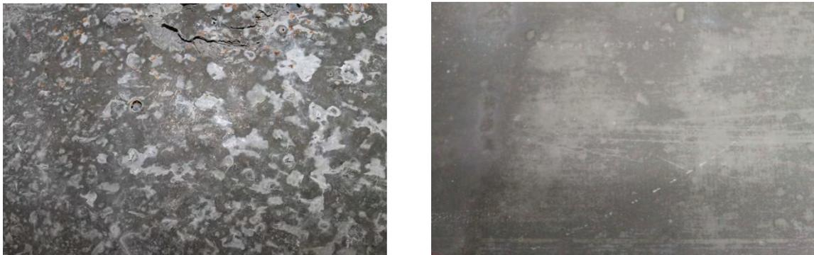
Abbildung 2.7: links: raue Oberfläche (sog. Elefantenhaut), rechts: glatte Oberfläche an der Schalungsseite
