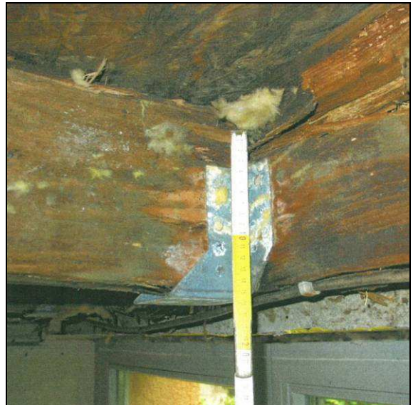
Abb. 40: Starke Verformung des Randbalkens aufgrund der zu großen Holzfeuchtigkeit
