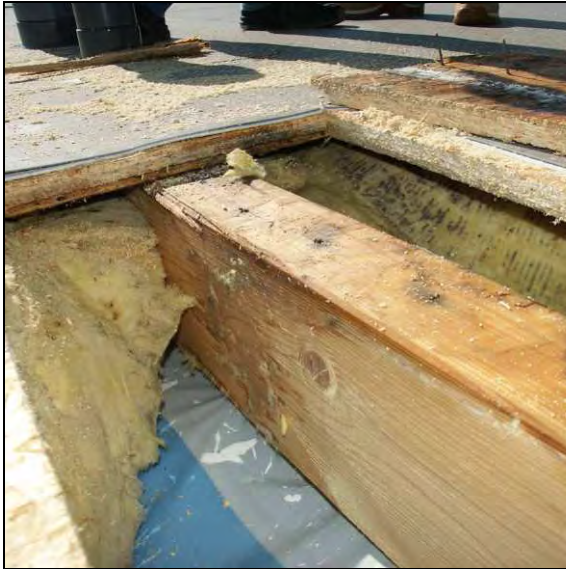
Abb. 13: Verschimmelte Mineralwollgedämmung
