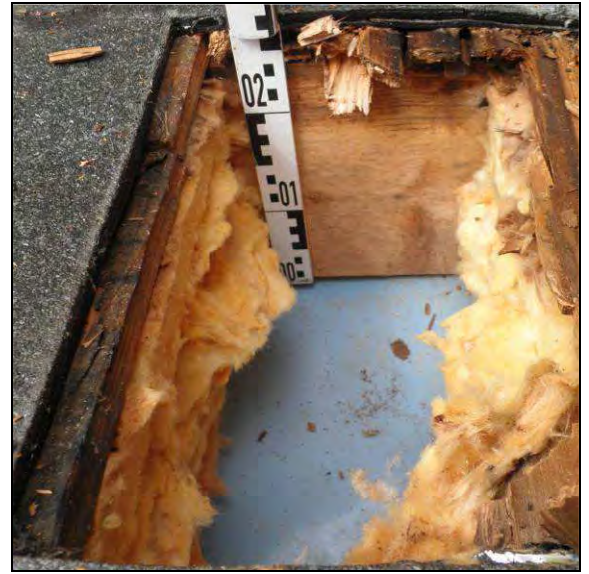
Abb. 24: Blick in die geöffnete Dachkonstruktion
