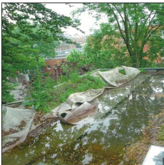
Abb. 28: Starke Pfützenbildung im Gründachaufbau
