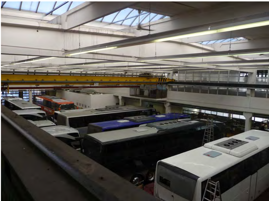
Abbildung 52: Blick in die Industriehalle A
