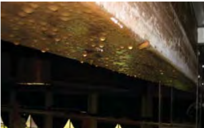
Bild 63: Tropfenbildung in einer Eishalle auf der Unterseite eines Hallenbinders 37
