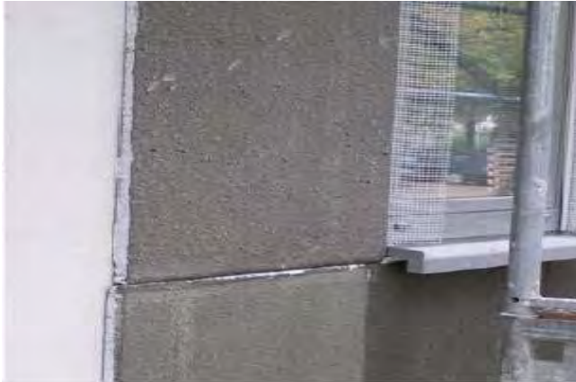
Bild 23: Anbringung von Vakuum-Isolier-Paneelen (VIP) an der Außenwand eines Gebäudes
