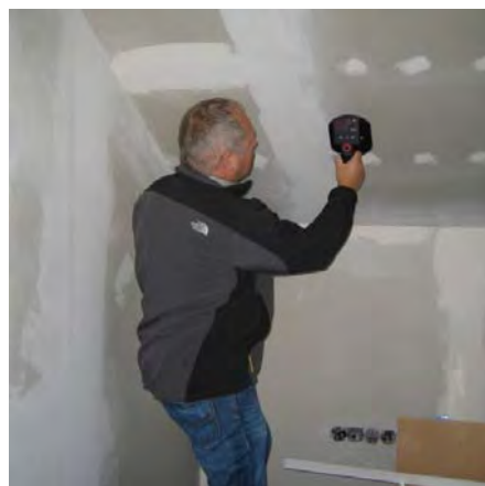
Bild 77: Ansicht des VIP-Paneels „VacuPad“ (links) und Auslese von VIP-Drucksensoren mit dem AEG-Reader durch die GK-Innenbekleidung.
