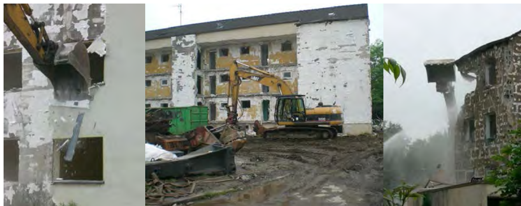
Bild 27: Mechanische Abschälen von WDVS mit EPS beim Rückbau eines Übergangs- wohnheims in Dortmund im Jahr 2009 (©Carsten Hördemann).
