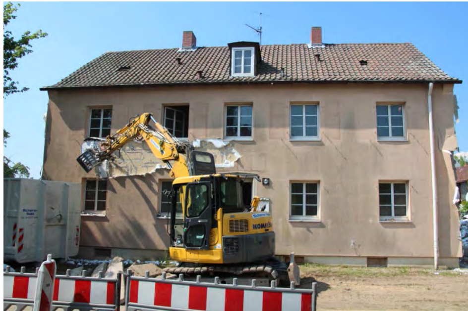
Bild 30: Rückbau eines Gebäudes (Ligustergang, Ludwigshafen).
