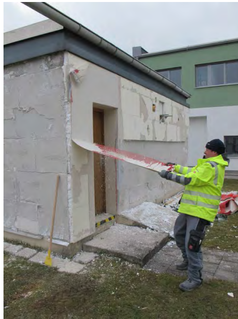
Bild 23: Abschälen der Decklage ohne Berücksichtigung des Abschälwinkels.
