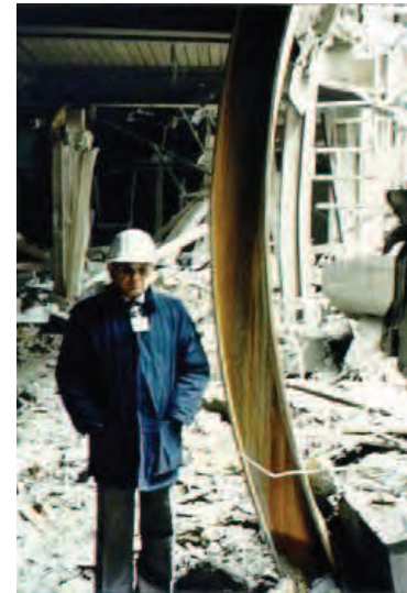
Abb. 1.3: Nach einem Bombenanschlag deformierte Stütze-Exchequer Court, St. Mary's Axe, London 1992 [53]
