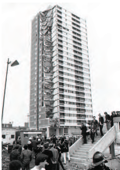
Abb. 1.1: Progressiver Einsturz des Ronan Point, London 1968 [57]
