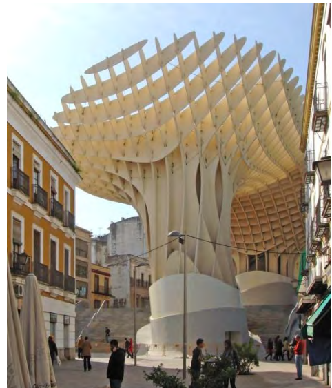
Abbildung 2-8: Metropol Parasol in Sevilla – Furnierschichtholz mit PUR-Dickfilmbeschichtung © V. Schmid
