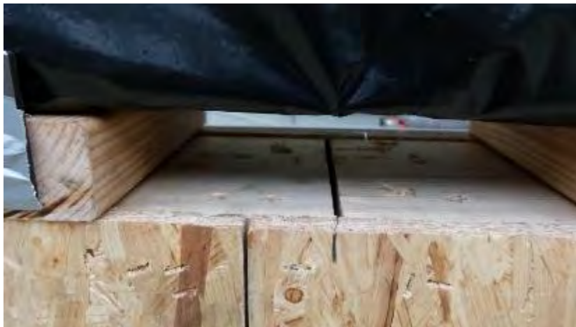
Abbildung 8-3: Vertikalfuge im Detail oben an der Wand
