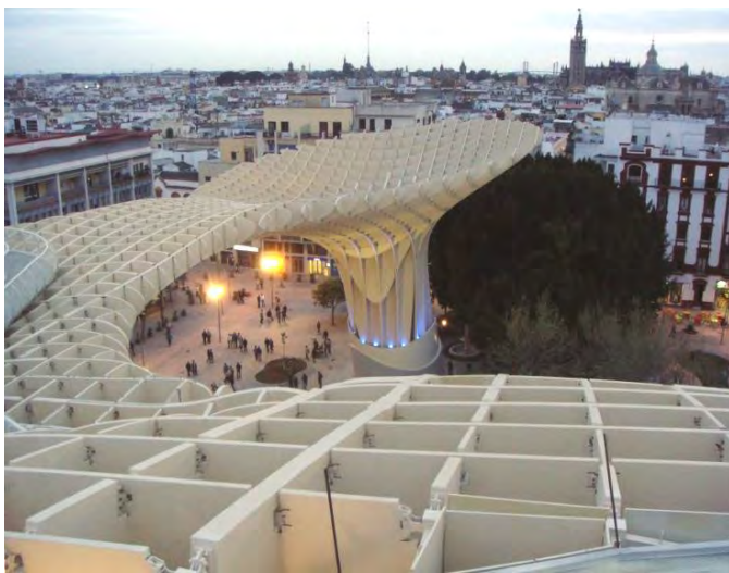
Abbildung 2-8: Metropol Parasol in Sevilla – Furnierschichtholz mit PUR-Dickfilmbeschichtung © V. Schmid
