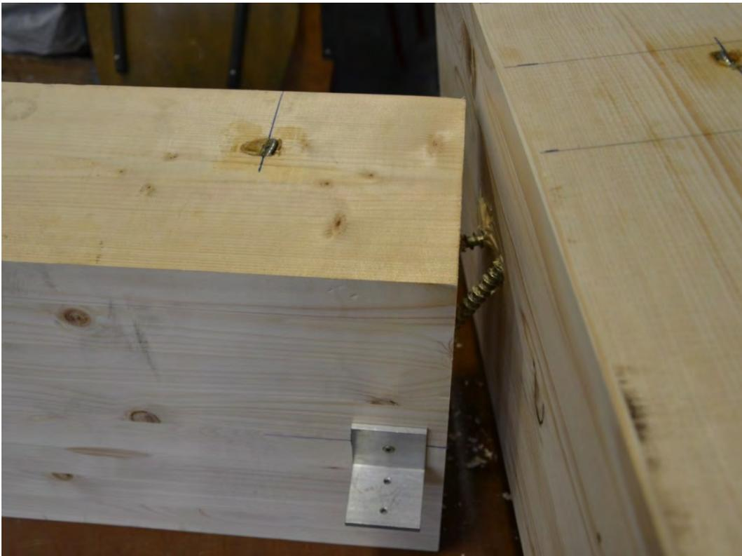
Abbildung 2-6: Ausziehen der im Hauptträger eingedrehten Schraube aus dem Nebenträger (vordere abgebildete Schraube)
