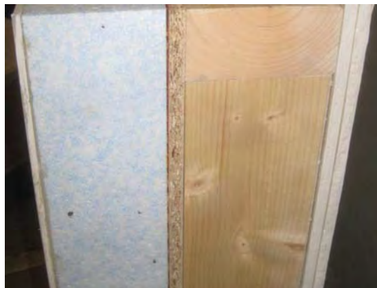
Abb. 23: Wärmedämm-Verbundsystem mit 100 mm Dämmstoffdicke auf der Holzständerwand. Im Unterschied zu den Massivwänden wurde die Dämmplatte in praxisüblicher Weise vollflächig mit der Außenschale der Wand (Spanplatte) verklebt. Die Auftragung des hierzu verwendeten Dispersionsklebers erfolgte mit der Zahntraufel. Die Dicke der Klebeschicht betrug ca. 4 mm.
