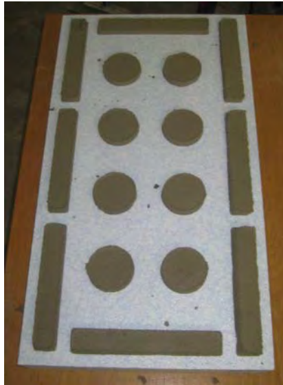
Abb. 14: Dämmstoffplatte aus Polystyrol vor der Befestigung auf der Grundwand. Der Klebemörtel wurde mit der in Abb. 13 dargestellten Schablone aufgetragen.
