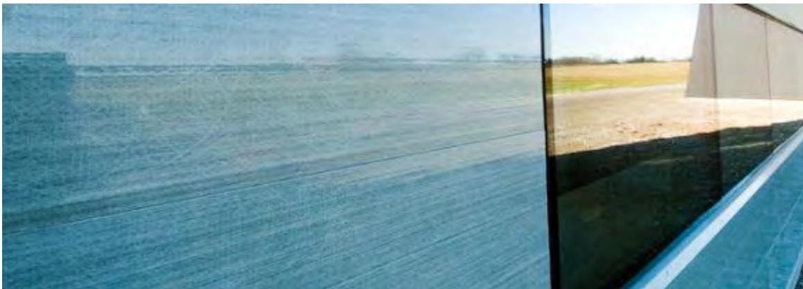
*Abbildung 42: Teil einer GFK-Fassade (Quelle: Fiberline Composites)*
