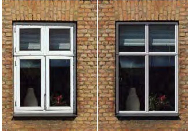
*Abbildung 2: Gegenüberstellung Fensterrahmen Thermoplast (links) GFK (rechts)*
