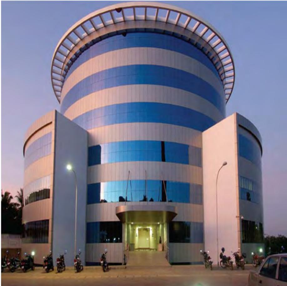
Abbildung 35: Beispiel einer Structural-Glazing-Fassade (Quelle: 3M)
