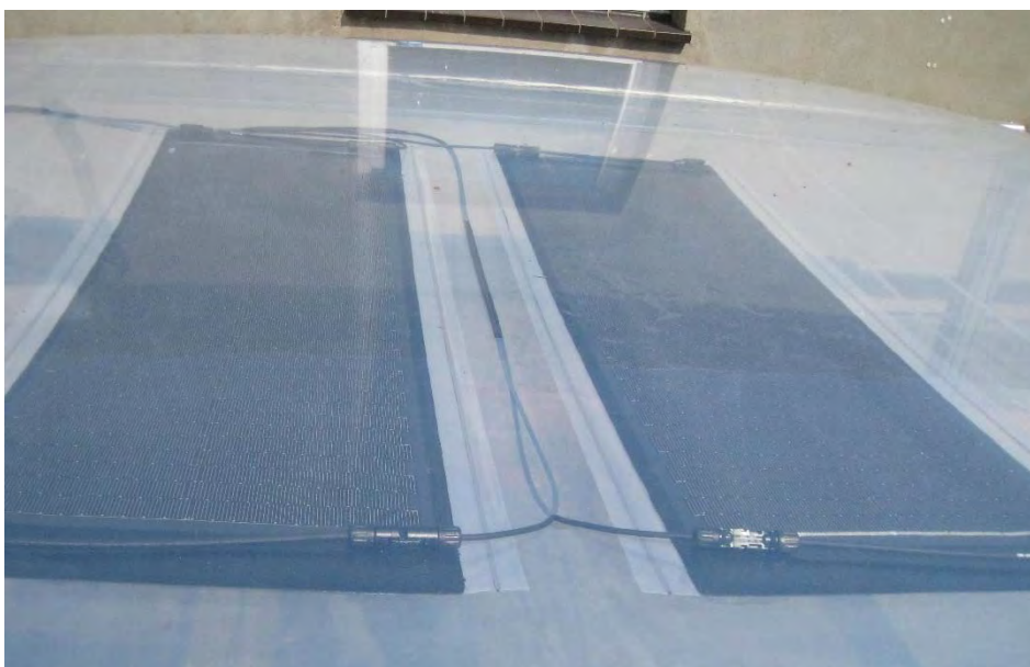
Bild 45 Kabelführung der innenliegenden PV-Module. Zur Stabilisierung wurden die Kabel durch die vorhandenen Löcher in der ETFE-Mittellage geführt.
