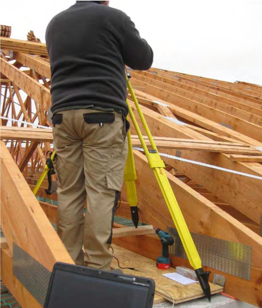
**Abbildung 20: Positionierung des Tachymeters auf einer provisorischen Plattform zwischen Trapezbindern**
