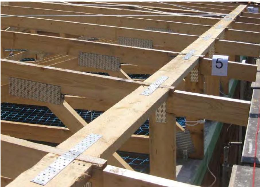
Abbildung 56: Zwischengeschnittene Bohlenstücke (Objekt 3)
