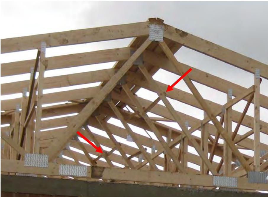
**Abbildung 58: Dachlatten auf den Diagonalen zur Montage (Objekt 5)**
