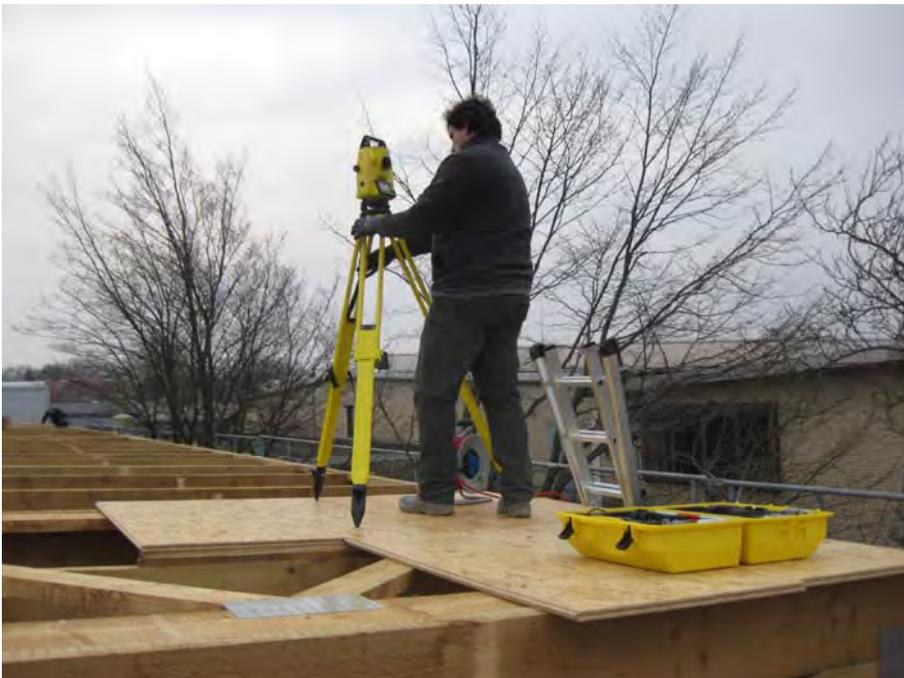
Abbildung 19: Positionierung des Tachymeters auf einer provisorischen Plattform auf einem Pultdachbinder
