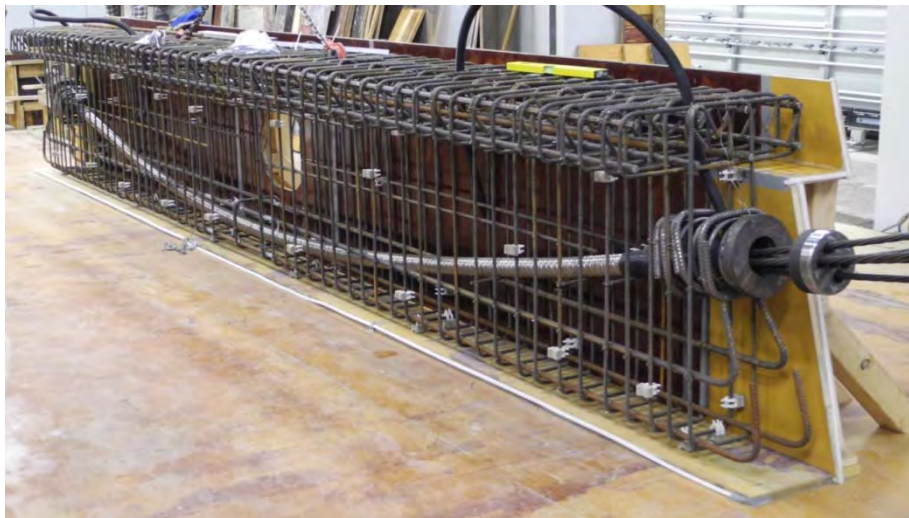
Bild B-3: Schalung und Bewehrung
