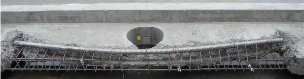
Bild B-7: Entnahme des Hüllrohrs
