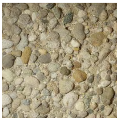
(a) Auftragsfläche vor Spritzbetongängung
