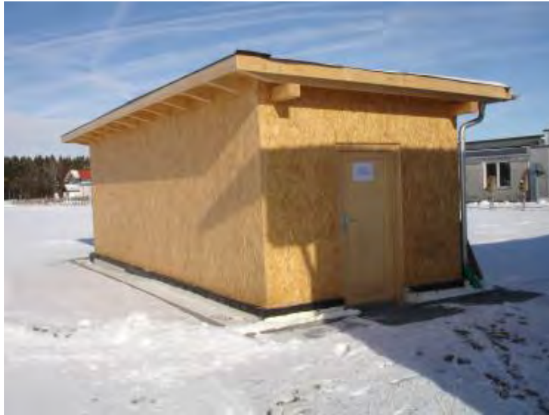
Bild 22: Süd-West-Ansicht des Versuchsgebäudes nach der Fertigstellung im Januar 2011.
