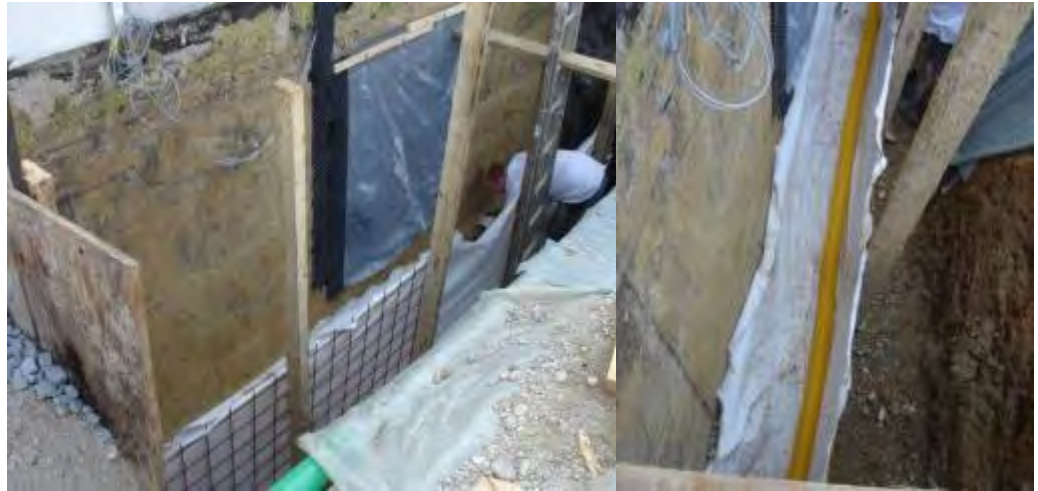
Bild 11: Ansicht der Hilfskonstruktion mit den ausgerichteten Balken, Baustahlmatte und Geotextil (links). Rechts sieht man das auf Geotextil verlegte Drainagerohr, welches in einen Sickerschacht geführt ist.
