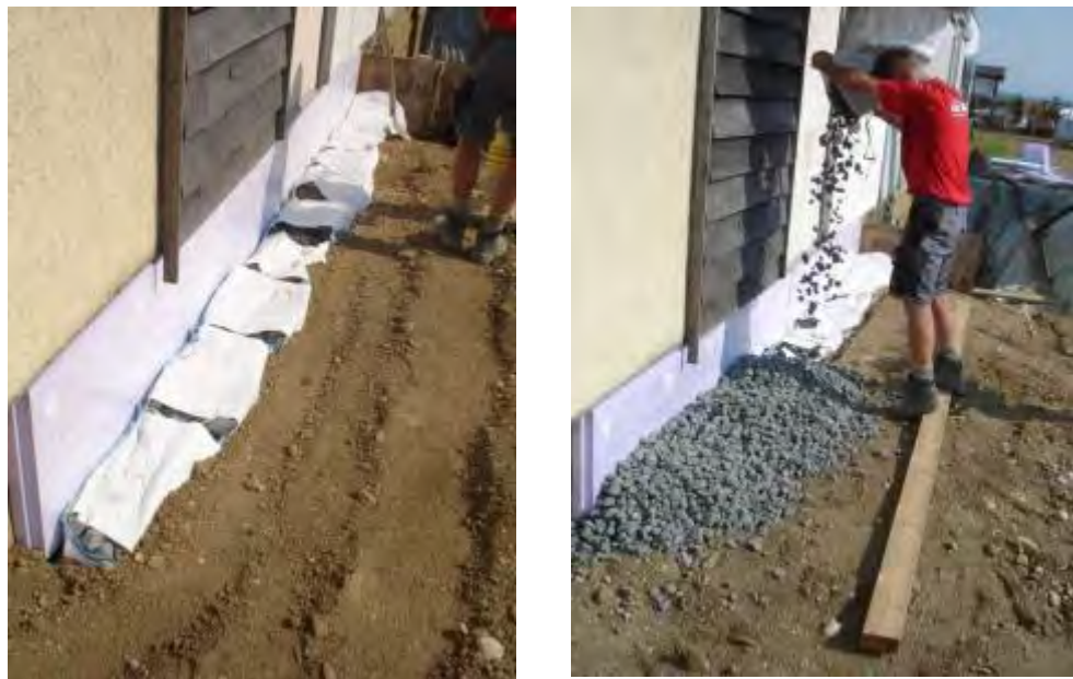
Bild 9: Umlegen der angenähten Laschen als Deckel des Taschensystems und Abdeckung mit Schaumglasschotter feinerer Körnung bei Material A.
