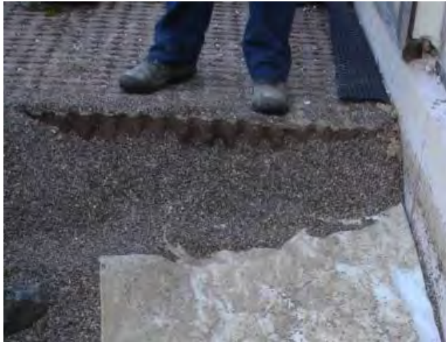
Bild 10: Abdeckung mit Geotextilstreifen und Verlegung von Rasengittersteinen im Splittbett im Bereich der Perimeterdämmung Material A.
