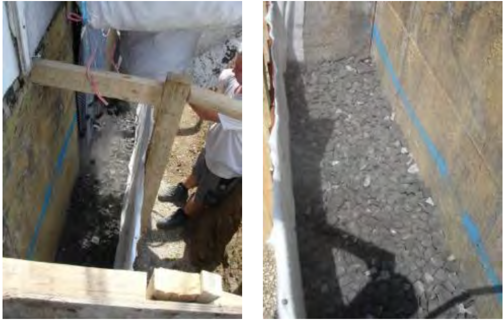
Bild 13: Weiteres Befüllen mit Schaumglasschotter bei Material B. Links Befüllen bis zur blauen Markierung, rechts nach Verdichtung auf gewünschten Verdichtungsgrad 1,3:1,0 (Abstand zur blauen Linie).
