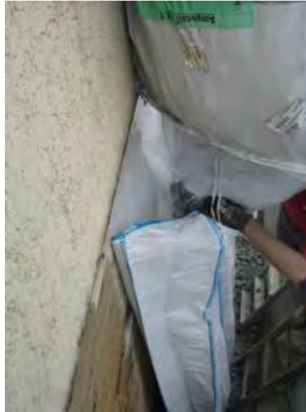
Bild 5: Erste Lage der Füllung mit dem in Bigbags angelieferten Material A in die erste Tasche des Taschensystems (linke Abb.). Rechts sind die zur Fundamentsohle hin offenen Taschen vor dem Einbringen des Kieses zu sehen.
