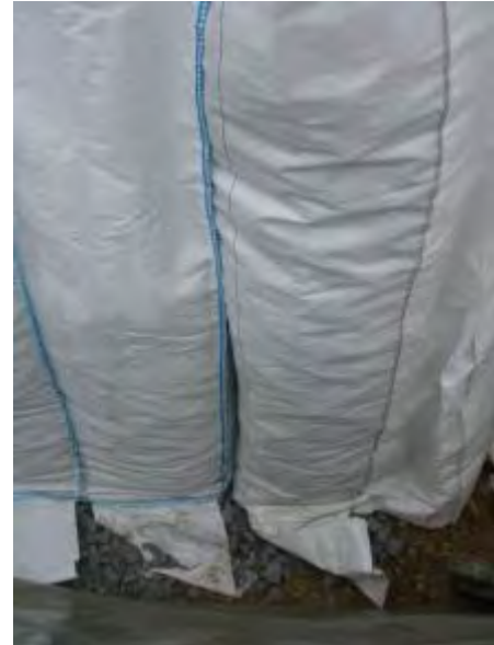
Bild 5: Erste Lage der Füllung mit dem in Bigbags angelieferten Material A in die erste Tasche des Taschensystems (linke Abb.). Rechts sind die zur Fundamentsohle hin offenen Taschen vor dem Einbringen des Kieses zu sehen.
