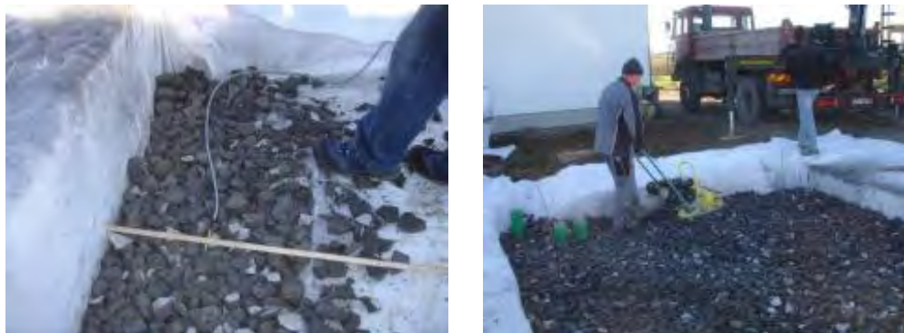
Bild 19: Verlegung der Sensorik auf Ebene Erdreich/Schaumglasschotter im Frostschirmbereich bei Material C (links) und das Verdichten der ersten Schaumglasschotterschicht bei Material B (rechts).
