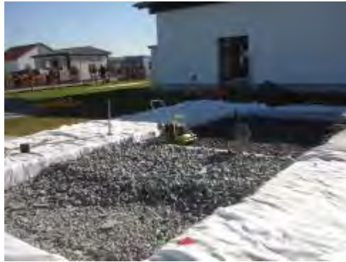
Bild 20: Einbringen und Verdichten der zweiten Lage des Schaumglasschotters und anschließendes Umschlagen des Geotextils.
