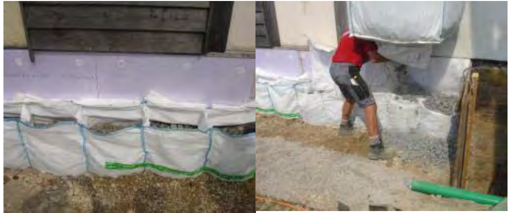
Bild 8: Ansichten der bis fast zur oberen Messachse verfüllten Baugrube und letzter Befüllvorgang des Taschensystems.
