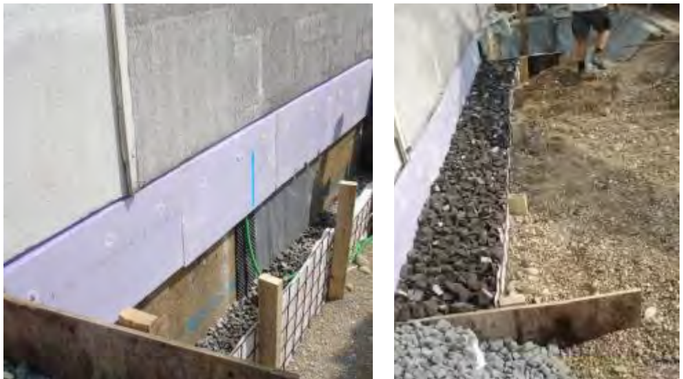
Bild 14: Letzter Befüllabschnitt, Anbringung der Sockeldämmung und Verfüllen mit Kies bei Material B auf gleiches Niveau wie bei Material A (Vordergrund).
