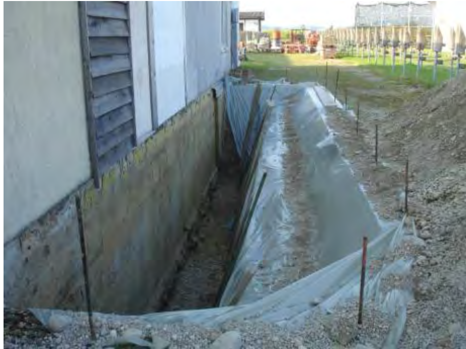
Bild 1: Ansicht der vorbereitenden Kellerwand an der Versuchshalle des IBP in Holzkirchen nach Aushub und Entfernen der bisherigen Perimeterdämmung Ende Juni 2010.
