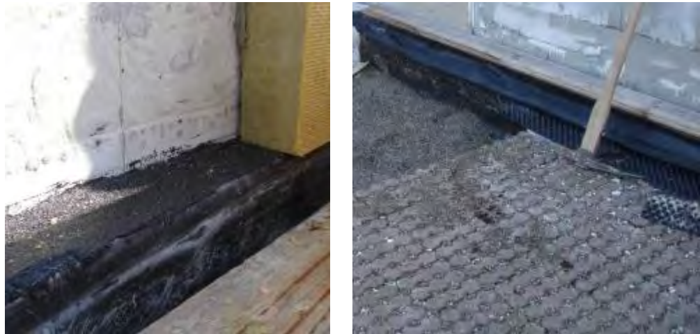
Bild 15: Anschluss der regendichten Abdeckung aus Teichfolie an das WDV-System der Fassade bei Material B und Verlegung der Rasengittersteine im Splittbett.
