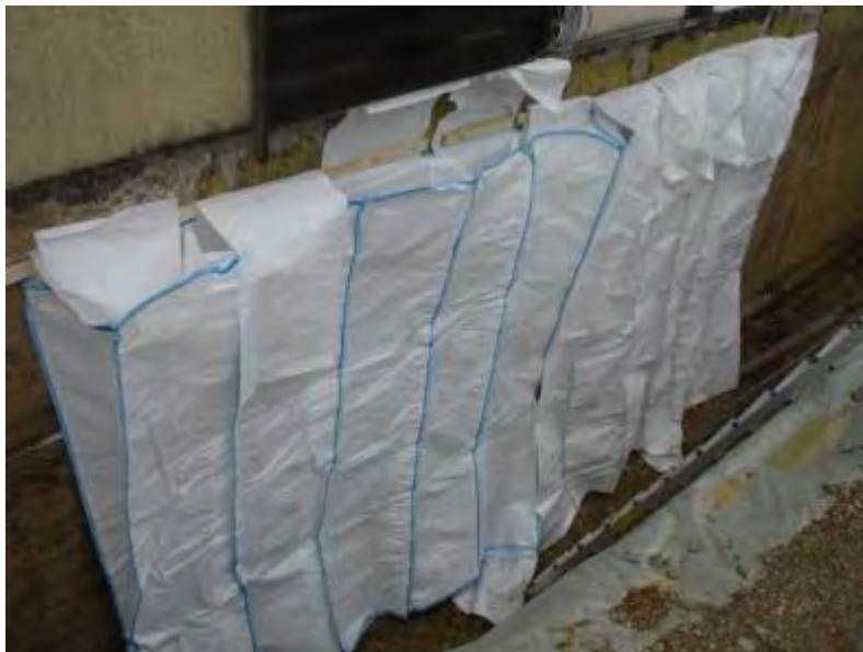
Bild 4: Ansicht der an der Wand zum Befüllen provisorisch fixierten Taschensystems des Materials A.
