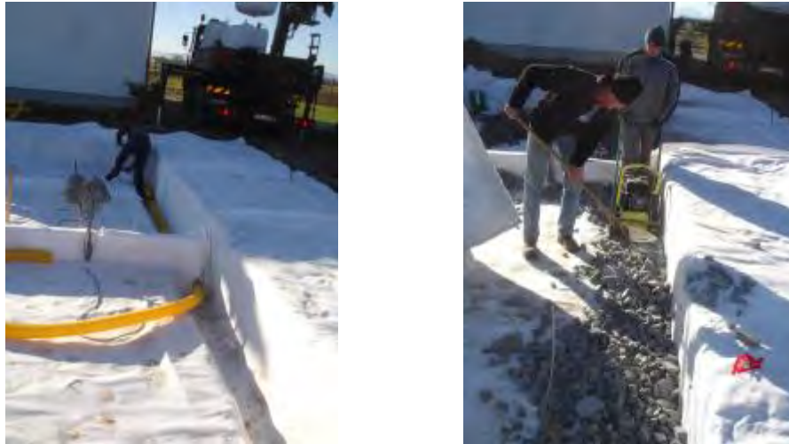
Bild 18: Verlegung des Geotextils und der Drainagerohre sowie Verfüllen des Drainagegrabens nach Aufteilung der Versuchsflächen für Material B (im Hintergrund) und Material C im Vordergrund.
