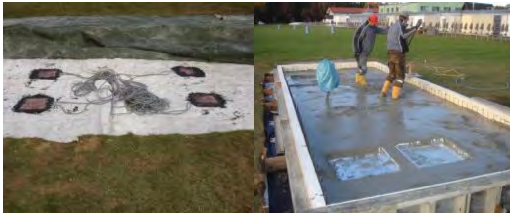
Bild 21: Installation der durch Kupferplatten geschützten Wärmestrommessplatten und Temperatursensorik oberhalb der Dämmschicht, für Material B und C für Plattenmitte und Randbereich (links) sowie Betonieren der Bodenplatte im November 2010 (rechts).
