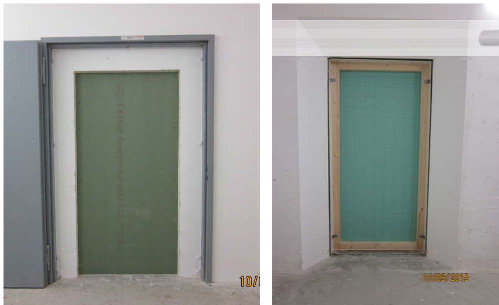
Bild 56: GKFI-Feuerschutzplatte auf Holzrahmen in der Prüföffnung des Türprüfstands. Linkes Bild: von Raum P9 aus gesehen; rechtes Bild: von Raum P10 (mit abgeschrägter Nische) gesehen.
