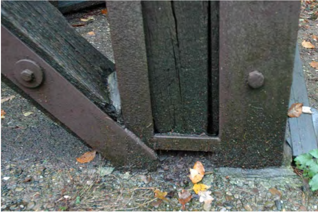
Abb. 25: Stützenfuß mit Strebenanschluss ohne Bodenabstand (38).
