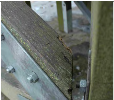
Strebenanschluss mit Fuge
