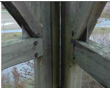
Riegel - Strebenanschluss
