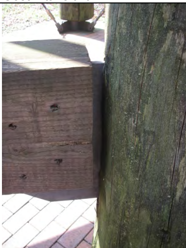
Anschluss Riegel an Stütze
