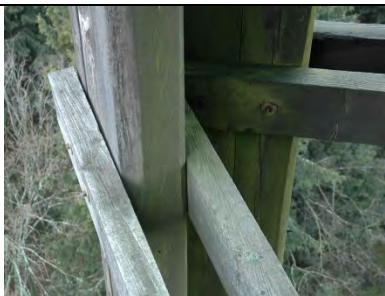
Riegelanschluss
