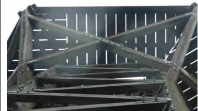
Stützen enden unter der Plattform
