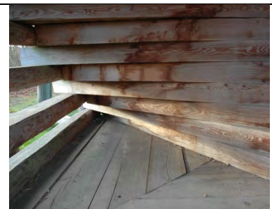
Unterseite Treppenbalken
