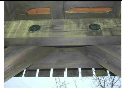
Strebenköpfe-Riegelanschluss
