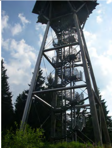
Gesamtansicht SW- Eckstütze nachträglich bekleidet
