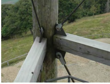
Anschluss Druckriegel mit Stahlzugstäben
