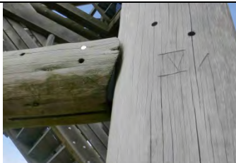
Riegelanschluss mit Fuge
