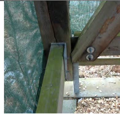
Stützenfuß innen Mit Spritzwasserschutz
