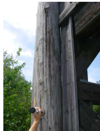
SSW-Eckstütze mit „Leiste“ eines Holz zerstörenden Pilzes. Diese Stütze auch von Ameisen besiedelt.
