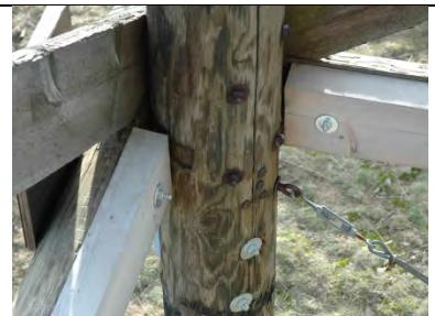
Riegelanschluss
