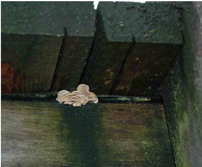
Abb. 21: Pilzfruchtkörper unter Belagsfuge, zwischen Abdeckung und Balken (15).
