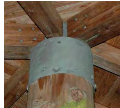
Stützenkopf unter Dach
