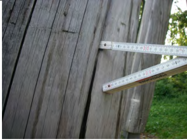
In einen andere Stamm kann der Maßstab 20 cm tief eingeführt werden
