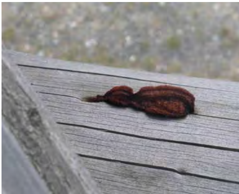
Abb. 19: Fruchtkörper an der Oberseite eines Rundholzriegels (74).
