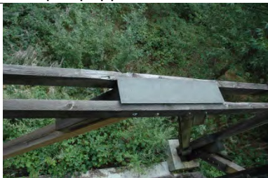
Horizontale Zangen mit Strebenanschluss. Strebenanschluss oben abgedeckt
