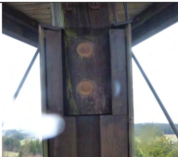
Anschluss der alten Stütze (DOU) an die neu Stütze (BSH)
