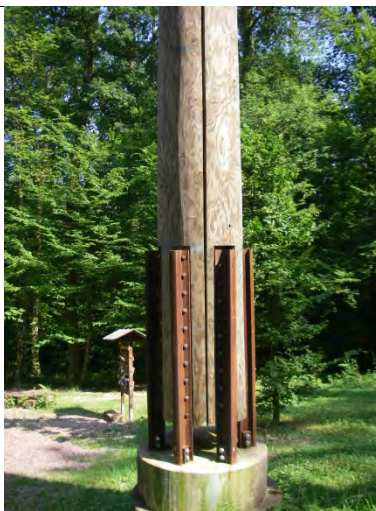
Stützenfuß Stütze mit ca. 5 cm tiefem Ent- lastungsschnitt versehen
