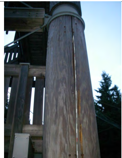
Spechtlöcher in Eckstütze ca. 10 cm tief
