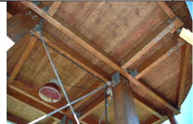
Untersicht Dach – Stützenköpfe
