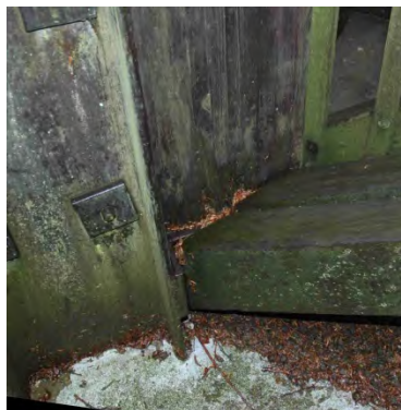
Stützenfuß mit Strebenan- schluss
