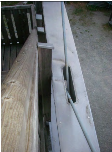
Geländerpfosten und Riegel sind abgedeckt. Stahl-Spannglieder werden durch die Blechverwahrung hindurch geführt.
