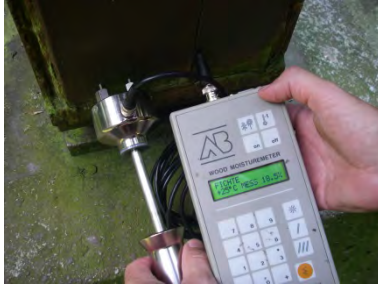
Holzfeuchte 18,5 % trotz mehrwöchiger Trockenheit in BSH-Stützenfuß
