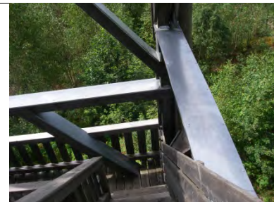
Riegel und Streben sind mit Blech abgedeckt.
