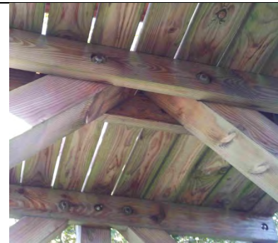
Strebenköpfe nur durch Belag geschützt
