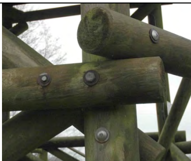
Knotenpunkt Stütze-Riegel-Strebe
