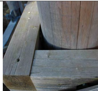
Riegelanschluss Innenkonstruktion
