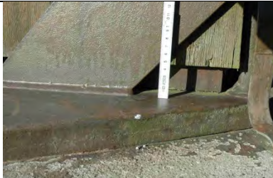
Stützenfuß – Hauptstütze
