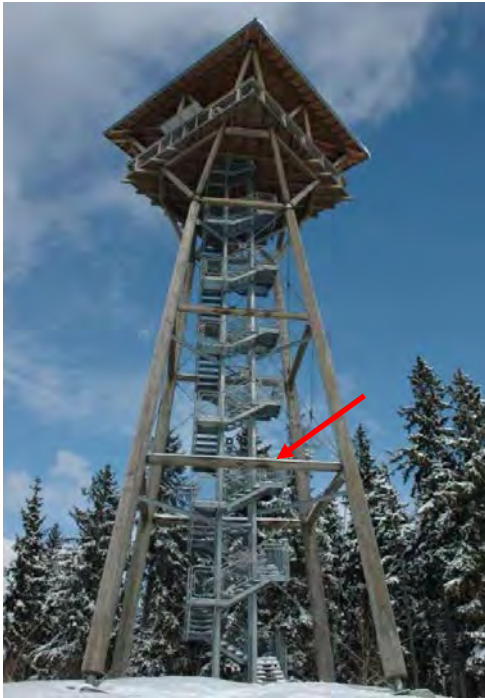
Abb. 3: Riesenhühlturm (Pfeil zeigt auf einen der ausgetauschten Querriegel) sowie die Stammscheibengewinnung aus den Querriegeln (rechtes Bild).
