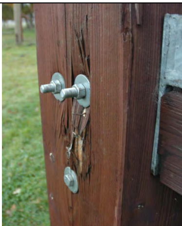
Quetschung an Verbindung
