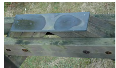
Streben-Riegelknoten mit Abdeckung
