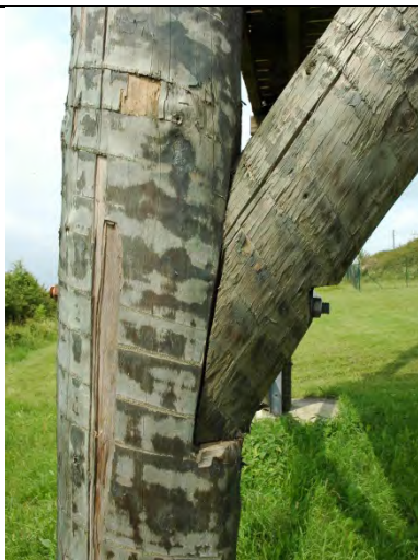
Bild 4 Strebenanschluss
