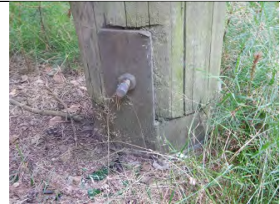
Stützenfuß „versinkt“ im Bewuchs und hat direkten Kontakt zum Erdreich
