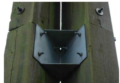
Stoß und Verbindung der Teil- stützen
