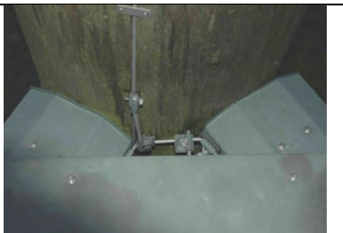
Riegelanschluss, Blech-Abdeckung besitzt End- Aufkantung
