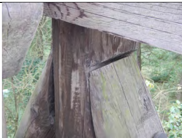
Kein Druck-Kontakt und damit keine Kraftübertragung zwi- schen Strebe und Stütze mög- lich
