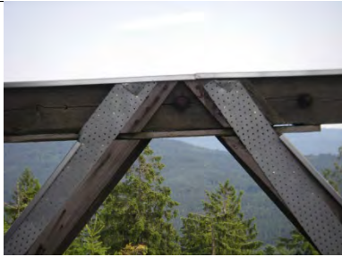
Strebenanschluss mittels Zinkblech und einigen wenigen Ankerägeln.
