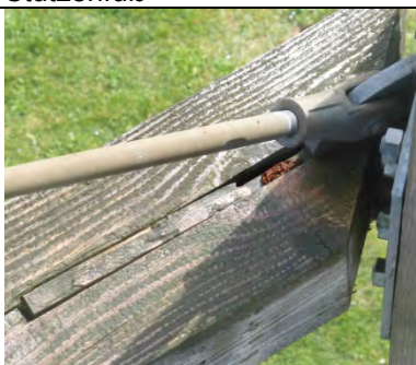
Die eingeschlitzten Platten wurden oben mit Leisten und
