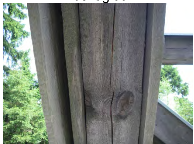
Tragbalken beidseitig mit Holz bekleidet und oberseitig mit Blech abgedeckt
