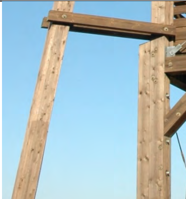
Zangen verbinden Strebe (außen) mit Stütze, Zusatzstütze vorgesetzt,
