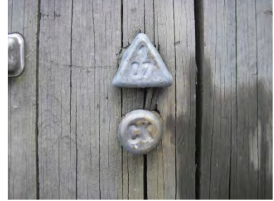
HSM-Kennzeichnung
