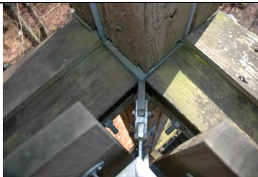
Knotenpunkt Horizontale Riegel mit geneigten Brettern abgedeckt.
