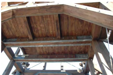
Konstruktion nachträglich durch Stahlträger verstärkt bzw. er- setzt
