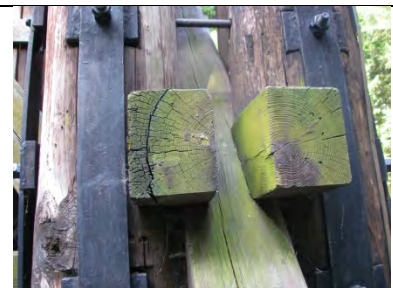
Anschluss Schnittholz-Riegel
