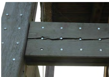
Knotenpunkt Trockenriss in Stabdübelachse des Druckriegels
