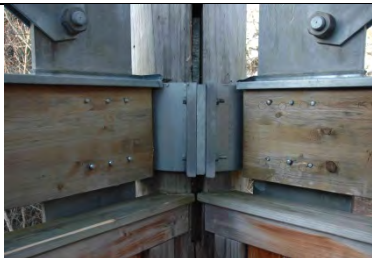
Riegelanschluss
