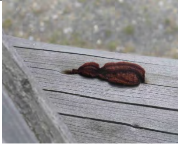
Pilzfruchtkörper an Riegel
