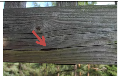
„Leiste“ eines Holz zerstörenden Pilzes
