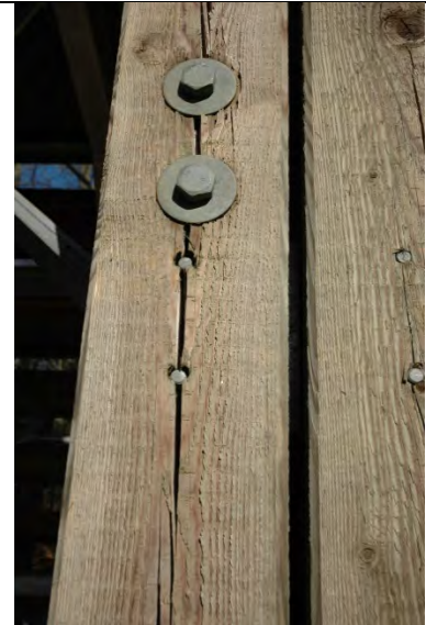
Trockenriss in Achse der Stabdübel
