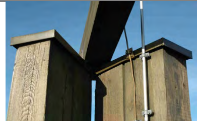
Stützenkopf Mit Blechabdeckung
