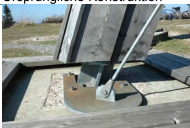
Stützenfuß Die neuen Stützen/Streben sind mit geschuppten Brettern be- kleidet.
