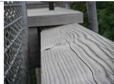
Horizontale Riegel wurden mit Gefälle hergestellt.
