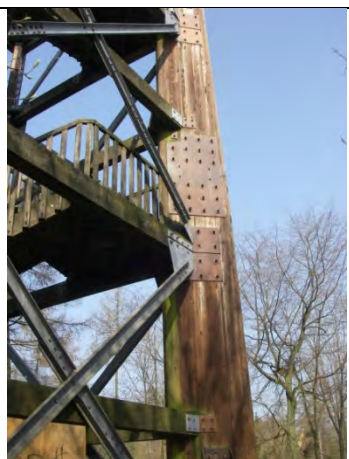
Stützenstoß mit Stahlknoten
