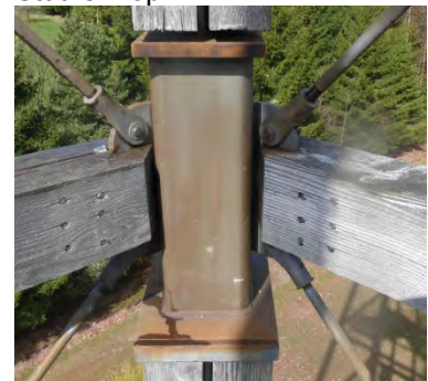
Knoten - Metallverbindung
