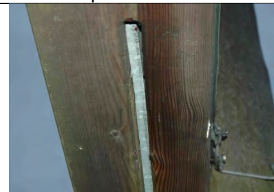
Riegelanschluss - Untersicht
