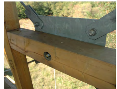
Stahlauskreuzung/Riegel
