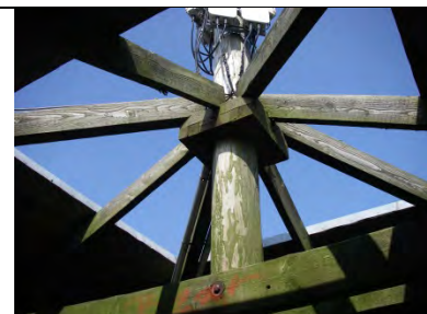
Kanzeldach – teilweise geöffnet Sparren ohne Abdeckung
