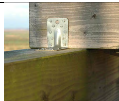
Podestbalken direkt auf Riegel verzimmert
