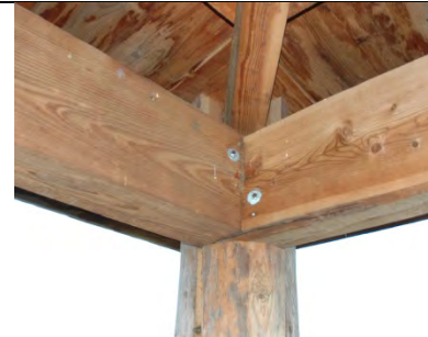
Stützenkopf Geschützt durch Dach
