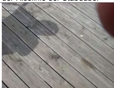
Geriffelte Belagsbretter der Po- deste ohne Gefälle
