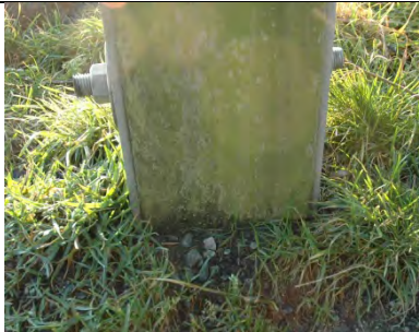
Stützenfuß bis ans Erdreich
