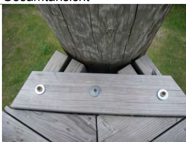
Riegelanschluss
