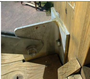
Anschluss Stahlauskreuzung
