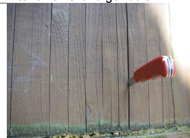
Messerklinge lässt sich mehrere cm tief in das BSH-Holz einfüh- ren. Delamierung. Grünalgenbefall
