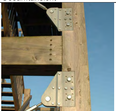
Knotenpunkt mit Riegel- und Zugbandanschluss
