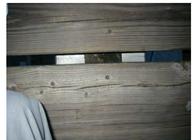
Zwischen Blechverwahrung der horizontalen Balken und dem Podestbelag wurden Distanzstreifen angeordnet.
