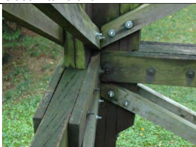
Anschluss Streben-Riegel
