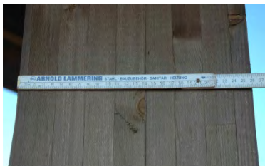
BSH-Strebe (außen), Lamellen 33 mm
