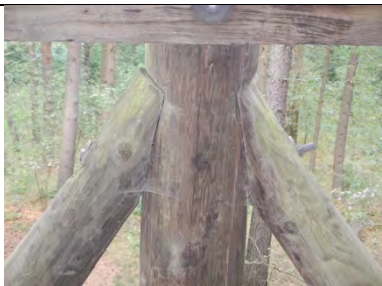
Druckstreben-Anschluss ohne direkten Kontakt. Klemmbolzen hat sich verformt
