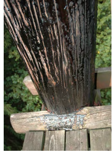
Teeröl „schwitzt“ aus dem Holz
