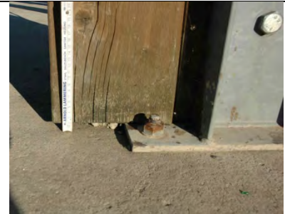
Vorgesetzte Zusatzstütze mit 2 cm Abstand zur Gründung
