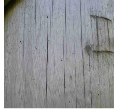
Stütze mit Ausfluglöchern
