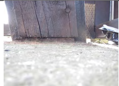
Zwischen Sohlplatte und Stüt- zenfuß befindet sich eine ca. 12 mm dicke Stahlplatte
