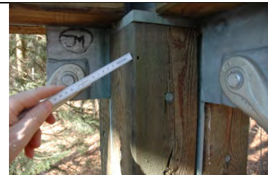
Stütze mit Insektenausflugloch
