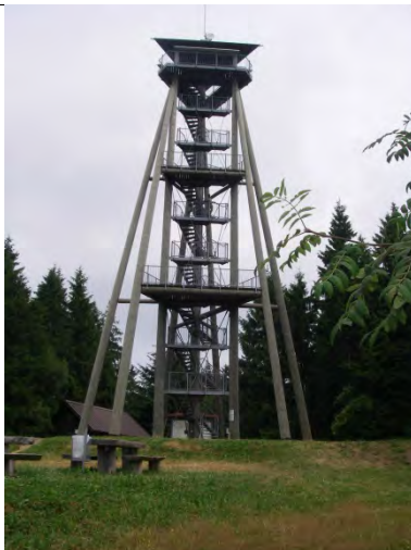
Gesamtansicht Strebenneigung \approx 65^\circ
