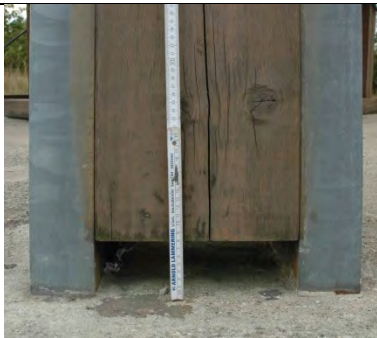
Strebenfuß, Außenstütze 8 cm Abstand zwischen Grün- dung und Unterkante Strebe
