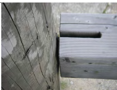
Riegelanschluss
