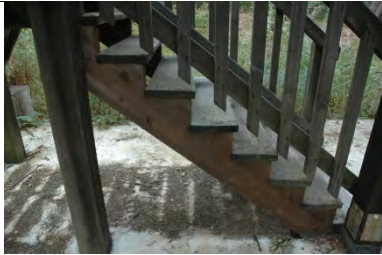
Treppe aus Holz Treppenstufen einteilig
