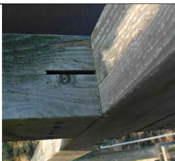
Riegelanschluss - Draufsicht
