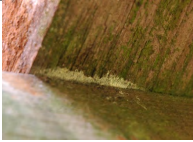
Bild 7 Bohlenaufleger von unten mit Pilzmyzel
