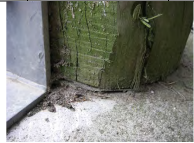
Stützenfuß Nach Zwischenschaltung einer Sperrpappe auf Betonsockel
