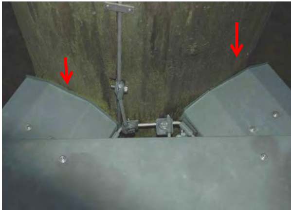
Abb. 36: Blechabdeckung horizontaler Bauteile (70).
