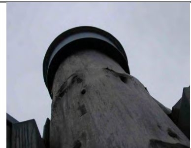
Stützenkopf außen Geschützt mit Blechformteil
