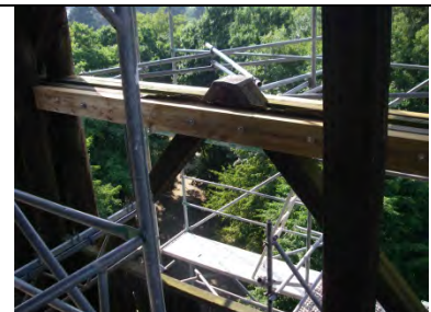
Reparaturstelle mit teilweisem Austausch von Hölzern. Ohne Abdeckung der Riegel Hirnholz der Streben abgedeckt
