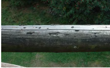
Pilz-Fruktkörper an horizontalem Riegel
