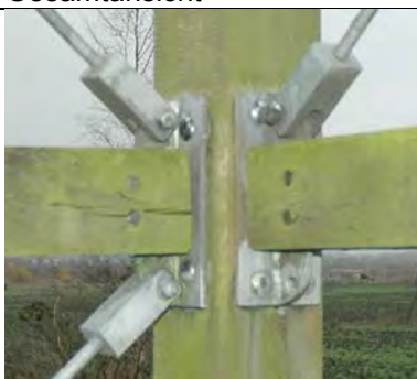
Stütze, Riegel, Zugseile
