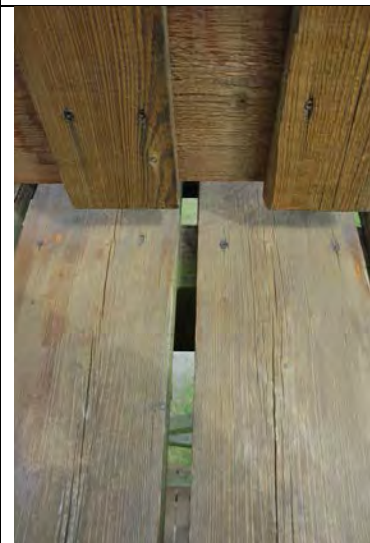
Bild 6 Bohlenauflager von oben
