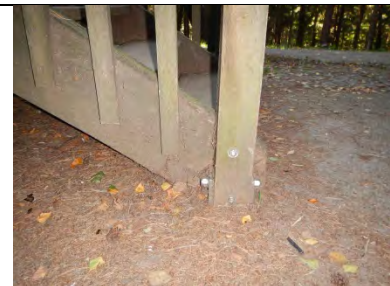
Treppenantritt auf Kleinpflaster
