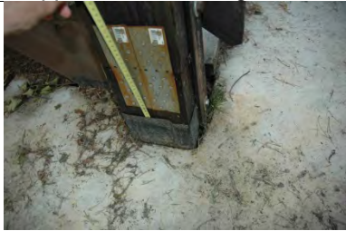
Treppenfosten einbetoniert. Mit Sperrpappe umhüllt
