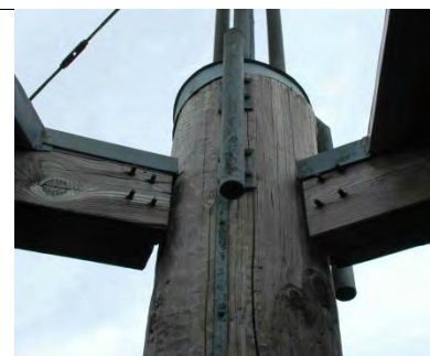
Kopf Mittelstütze Blechabdeckung der Riegel
