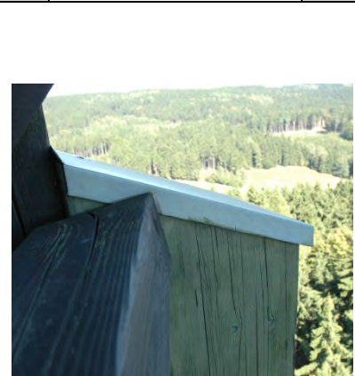
Stützenkopf – Abdeckung
