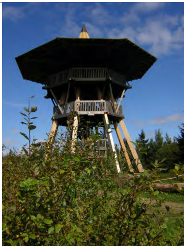
Gesamtansicht Sanierte Konstruktion Der Dachüberstand wurde deut- lich vergrößert.
