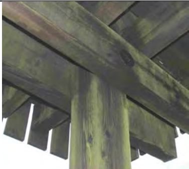
Stütze mit Riegelanschluss
