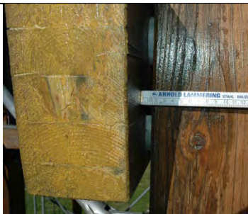
Abstand Riegel – Stütze
