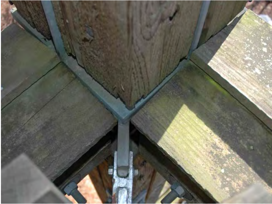
Abb. 17: Riegel mit oberseitiger Bretterabdeckung am Stützenanschluss.
