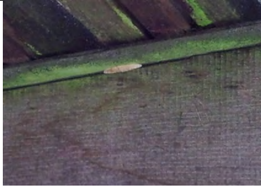
Kleiner Fruchtkörper am selben Balken
