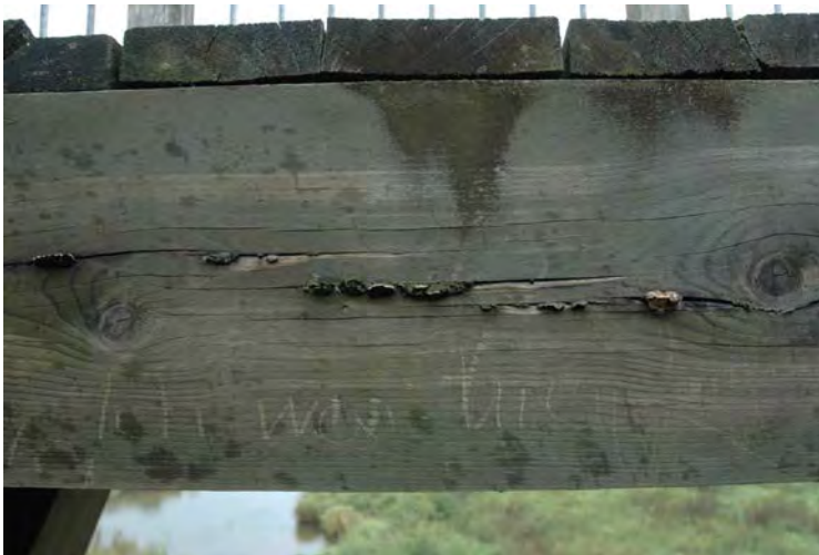
Abb. 16: Fruchtkörper von Blättlingen an KD-imprägniertem Fichtenkantholz (Turm 39).
