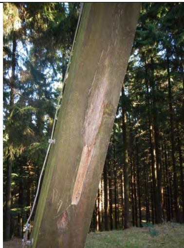
Fehlstellen wurden herausgeschnitten
