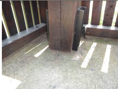
Stützenfuß Geschützt durch Dach des EG
