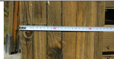
Stützenbreite 240 mm, Lamel- lendicke 40 mm
