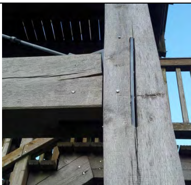
Knotenpunkt Anschluss Druckriegel an Stüt- ze
