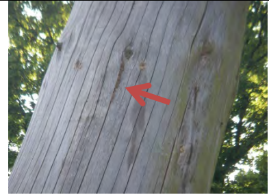
„Leiste“ eines Holz zerstörenden Pilzes
