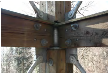
Knotenpunkt Stützenstoß mit Anschluss der Riegel und der stählernen Verbandsstäbe Die horizontalen Riegel sind abgedeckt mit geneigten Holzbrettern
