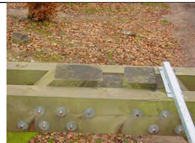
Anschluss Streben an Zangen- Riegel nicht abgedeckt
