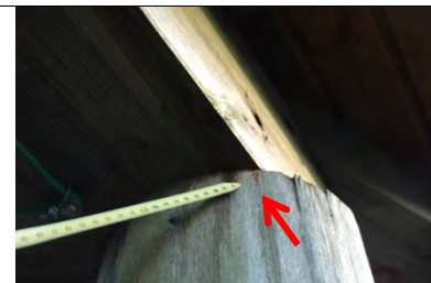
Stützenkopf Mit Gallerträne
