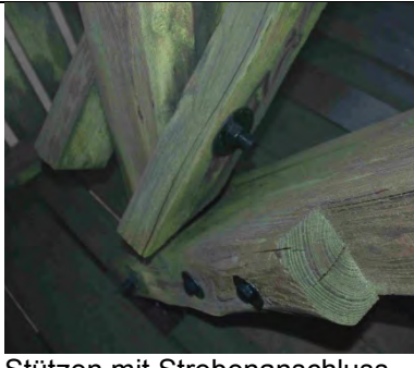
Stützen mit Strebenanschluss
