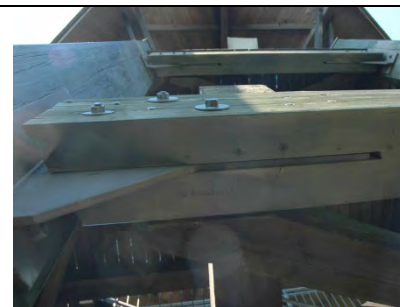
Anschluss Stütze – Riegel
