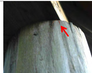
Stützenkopf Mit Gallerträne
