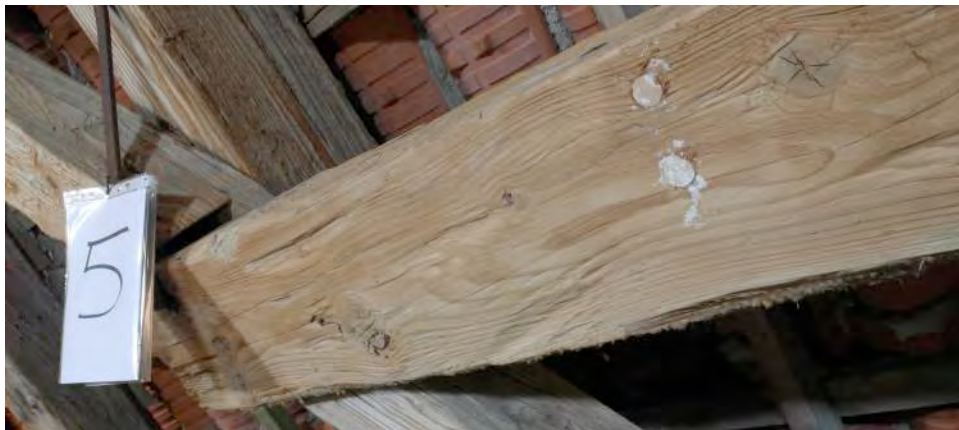
Abb. 37 Naumburg, Dom, Feld 5, Zustand nach Polyacrylatbeschichtung (11.3.2014)
