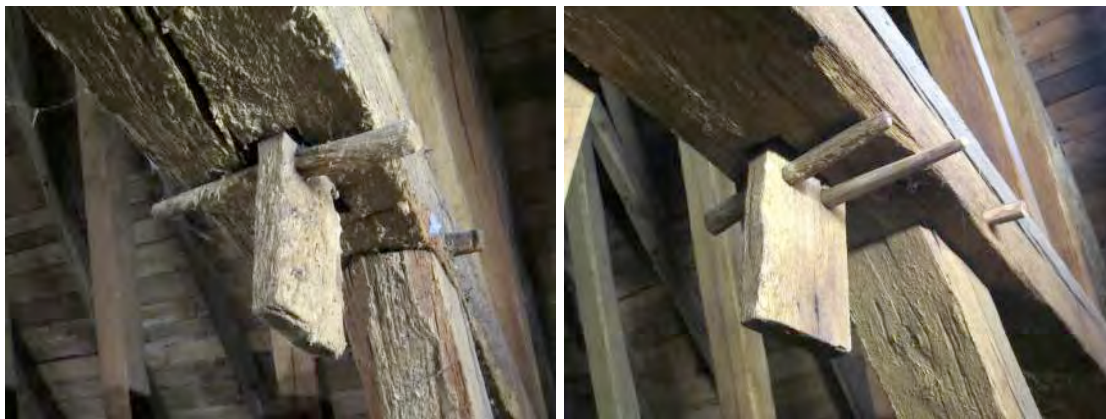
Abb. 32, 33 Meisenheim, Schlosskirche, Zapfenschlösser vor und nach Reinigung mittels rotierender Kunststoffbürste
