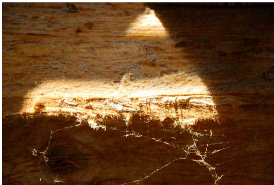
Abb. 15 Wittenberg, Lutherhaus (Ostteil des Daches): Mazeration nach Reinigung
