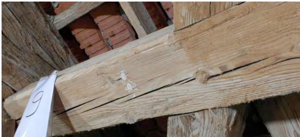
Abb. 39 Naumburg, Dom, Feld 9, Zustand nach Bariumacetatapplikation (11.3.2014)
