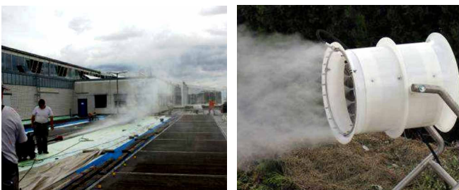
Abb. 10: Benebelung einer Betonoberfläche mit der Nebellanze
