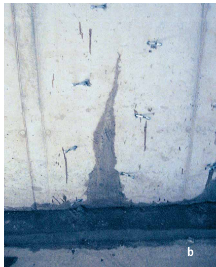
Abb. 1: Beispiele für wasserführende Risse (a, b) und eine undichte Arbeitsfuge (c)
