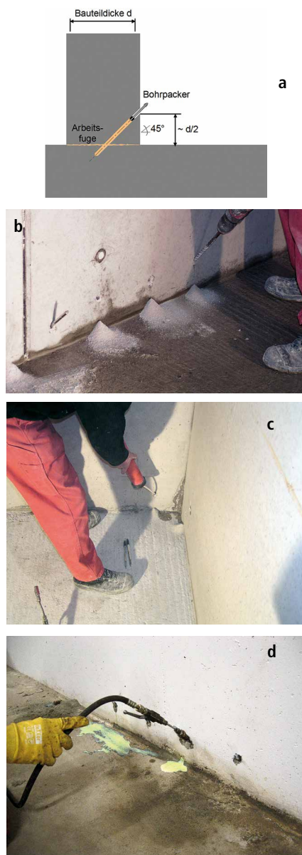
Abb. 5 a, b, c, d: Verpressung einer Arbeitsfuge zwischen Bodenplatte und Wand (a: Prinzipskizze, b: Bohren der Injektionskanäle, c: Säubern der Bohrkannäle von Bohrmehl durch Ausblasen, d: Ausführungsbeispiel)
