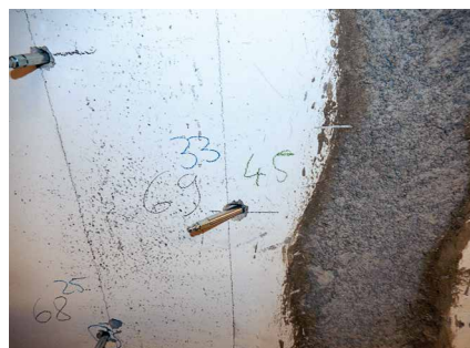
Abb. 8: Beispiel für die Kennzeichnung von Bohrungen/Bohrpackern (schwarz: Nummer des Bohrpackers, blau: Bohrtiefe, grün: Bohrwinkel)
