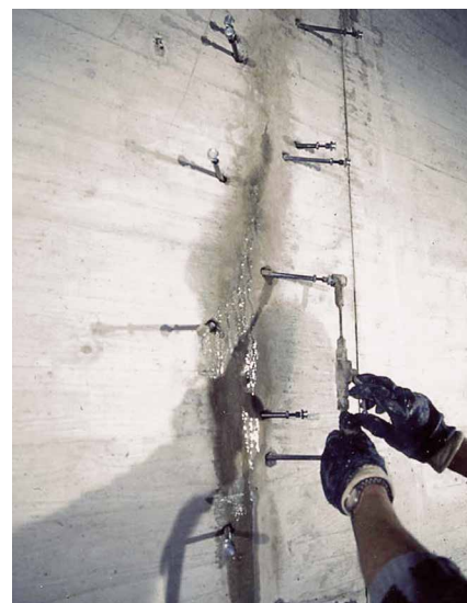
Abb. 3: Anordnung der Bohrpacker bei der Rissverpressung
