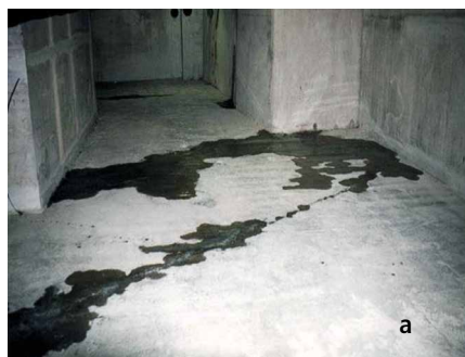
Abb. 1: Beispiele für wasserführende Risse (a, b) und eine undichte Arbeitsfuge (c)
