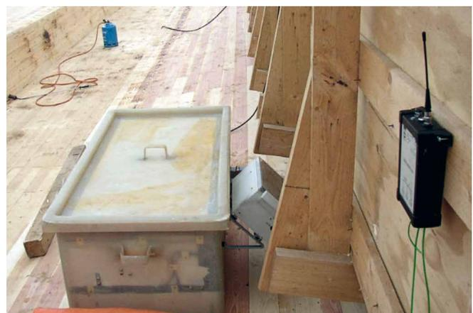
Abb. 2: Einsatz der Klimatrübe auf der Baustelle, Ansteuerung durch die Bauteiltemperatur [Eng]
