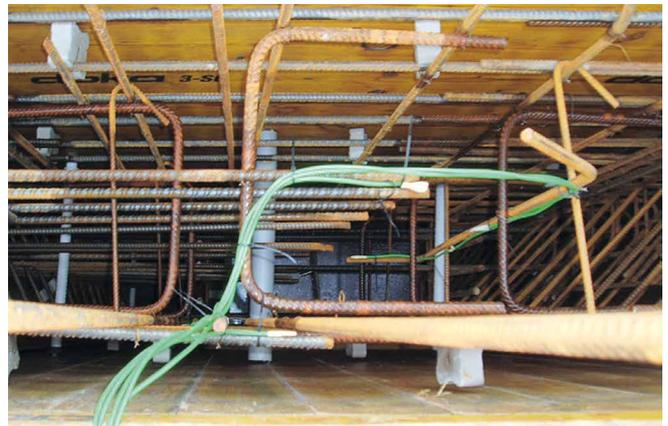
Abb. 14: Einbau der Messfühler in die Schalung und Befestigung an der Bewehrung (Aufnahme: [Engl])
