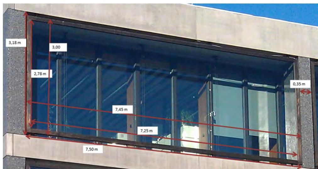
Bild 25: Maße zur Ermittlung der Lüftungsquerschnitts der Glasdoppelfassade (siehe Tabelle 34).
