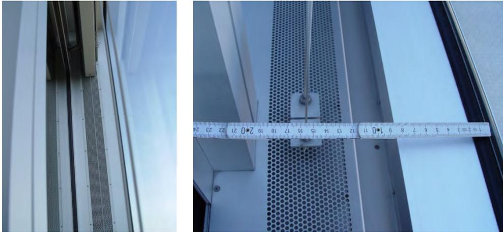
Bild 8: Blick in den Fassadenzwischenraum der Glasdoppelfassade, linkes Foto: Blick nach oben mit Lamellenraffstore; rechtes Foto: Blick auf die Brüstung.
