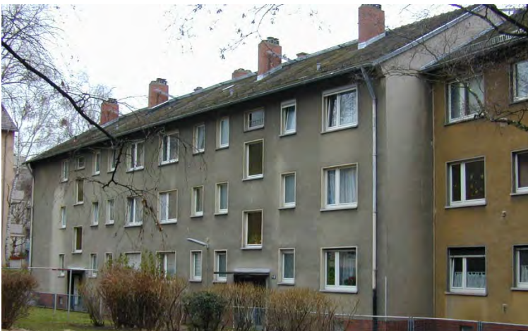
Bild 39: Alte Kamine, die vor der Montage einer PV-Anlage möglichst entfernt werden sollten
