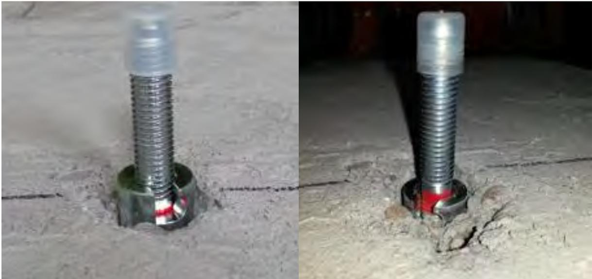
Abb. 6-13 Hinterschnittanker Hilti HDA-P – linkes Bild: vor dem Einbau; rechtes Bild: nach dem Einbau
