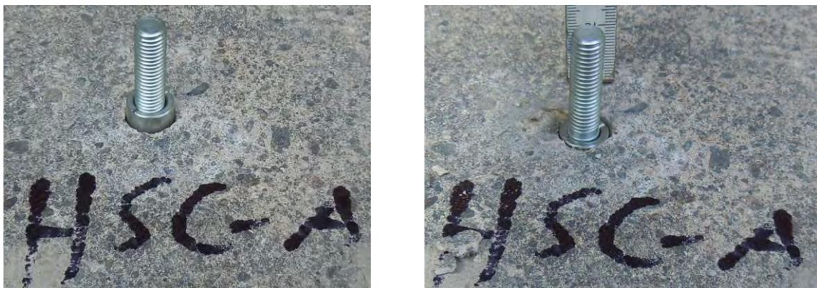
Abb. 6-3 Hinterschnittanker Hilti HSC-A – linkes Bild: vor dem Einbau; rechtes Bild: nach dem Einbau
