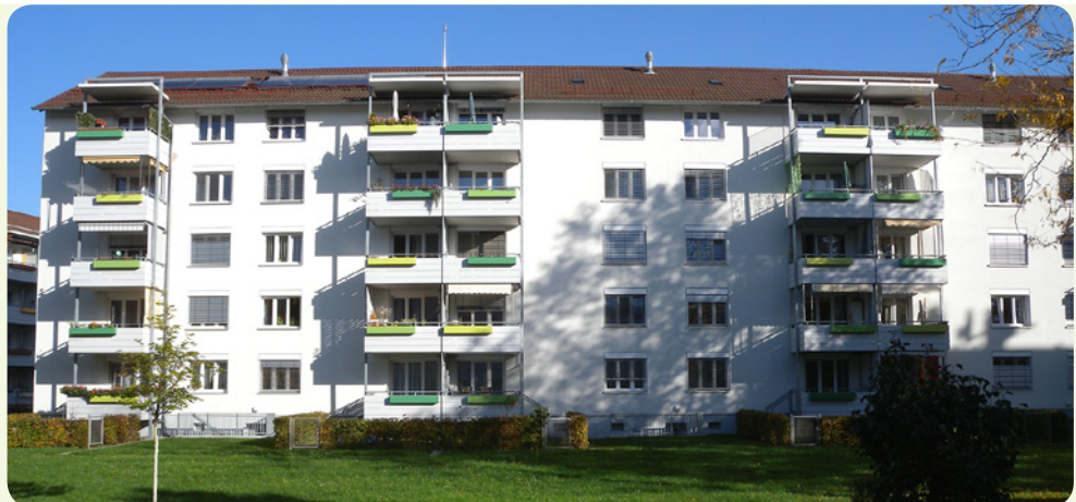
Abb. 4-3: Westfassade eines Gebäuderiegels nach der Sanierung, Quelle: E.ON ERC EBC
