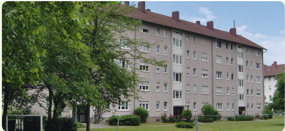
Abb. 4-1: Gebäuderiegel vor der Sanierung, Quelle: VOLKSWOHNUNG Karlsruhe
