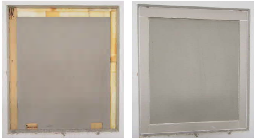
Abb. 9: Im Fensterprüfstand eingebauter Versuchsaufbau vom Senderraum aus gesehen: Ausfüllen der umlaufenden Fugen mit schallabsorbierendem Schaumstoff (links) und anschließendes Verschließen der Fugen mit Gipskartonstreifen und Acryl (rechts).
