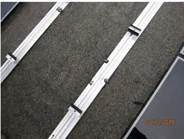
Abb. 14 Befestigung der Aluprofile mit Schrauben durch die Dachabdichtung
