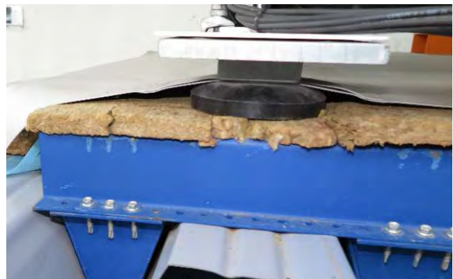
Abb. 77 Lastabtragung auf die tragende Konstruktion durch einen Wechsel aus Stahlprofilen über die Trapezblechschale
