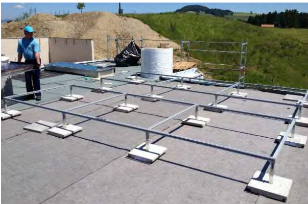
Abb. 87 Traggestell wird auf vorgefertigte Stützenfüße montiert
