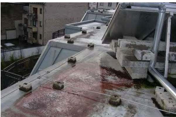
Abb. 64 Die Solarkollektoren stehen sehr nah am freien Dachrand des viergeschossigen Mehrfamilienhauses.
