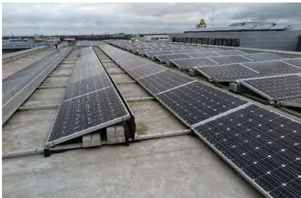
Abb. 78 Ballastoptimiertes System mit Auflagerfüßen aus „Ultramid“
