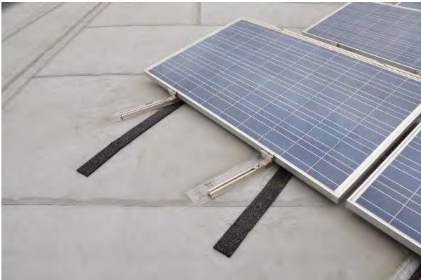
Abb. 60 Verrutschte Bautenschutzmatte
