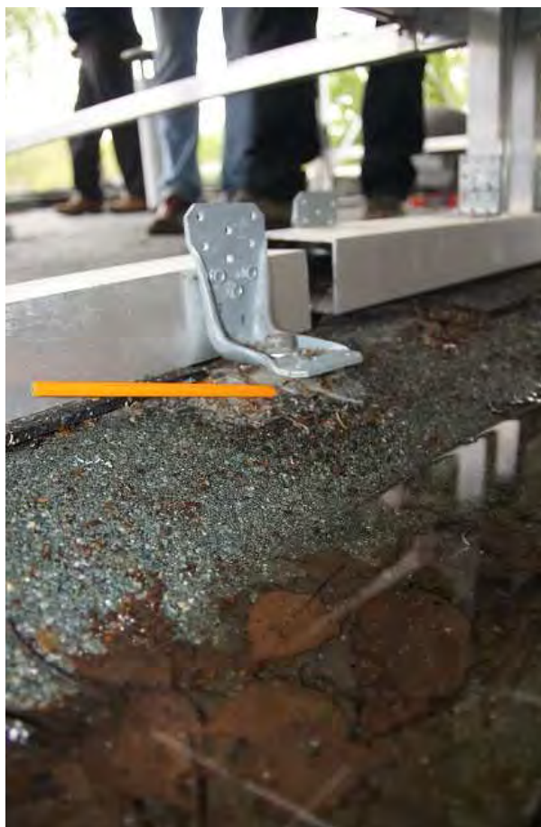
Abb. 23 Die „Lastverteilung“ des Montagesystems erfolgte mittels Aluminium-Rechteckprofilen.
