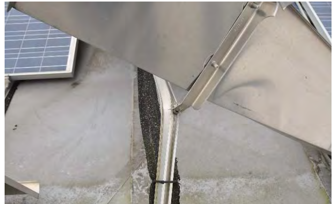
Abb. 61 Sicherung der Bautenschutzmatte an anderen Stellen durch Kabelbinder
