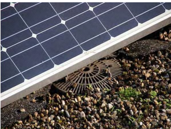
Abb. 5 Einbausystem aus hohen Wannen auf bekiessten Dächern
