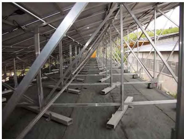
Abb. 23 Die „Lastverteilung“ des Montagesystems erfolgte mittels Aluminium-Rechteckprofilen.
