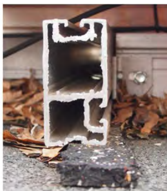
Abb. 47 Abrutschen des Alu-Profils von der Bautenschutzmatte [Quelle: www.dgs-berlin.de ]
