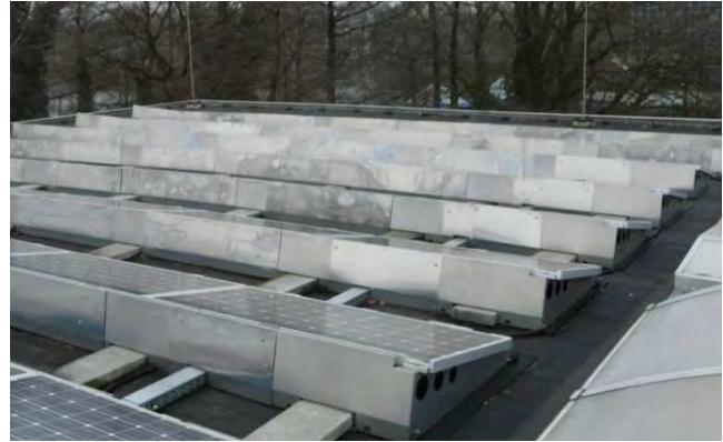
Abb. 90 Zwischen den Modulreihen wurden keine Bautenschutzmatte ausgeführt, um einen Wasserablauf zu ermöglichen.
