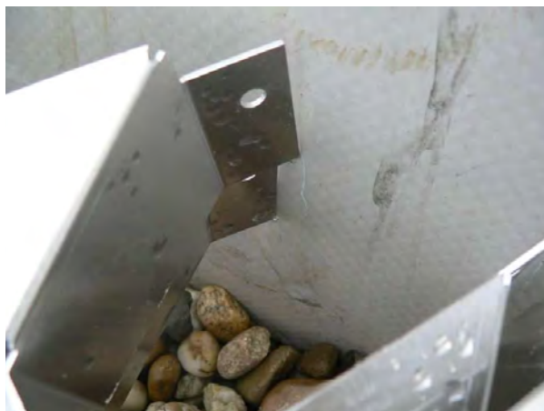
Abb. 11 Scharfkantige Metallbauteile stoßen an die nur ca. 1,5 mm dicke Kunststoffabdichtungsbahn an der Randaufkantung.
