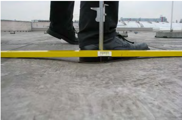
Abb. 40 Messung der Einsinktiefe
