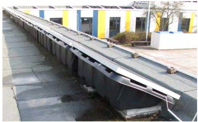
Abb. 98 Foto eines hohen Wannensystems
