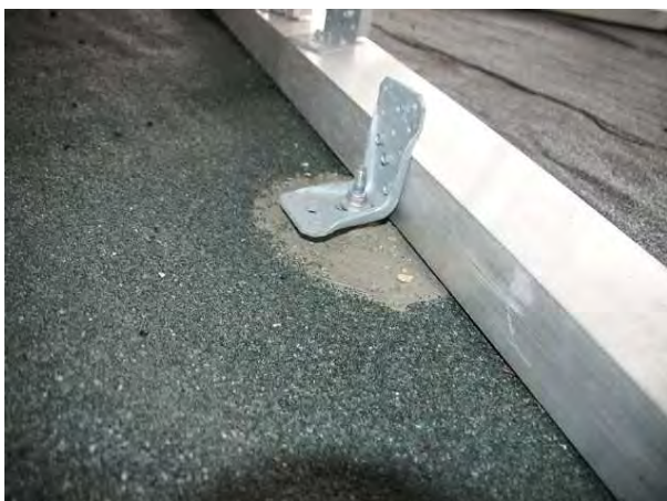
Abb. 24 Die Lagesicherung der Rechteckprofile erfolgte durch Winkel- laschen und Verschraubung mit dem Untergrund.
