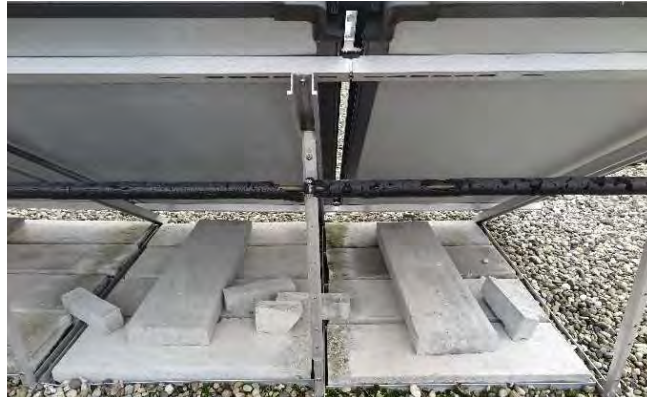
Abb. 92 Die Ballastierungselemente sind zwischen den Tragprofilen angeordnet.
