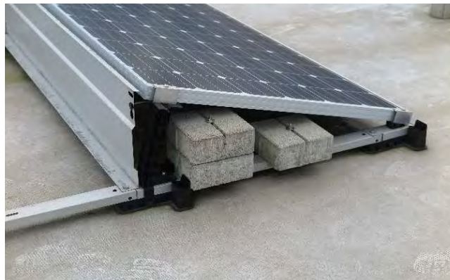
Abb. 79 Ballastierung durch vorgeformte Betonelemente
