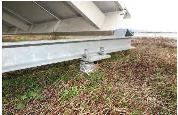
Abb. 71 Befestigungsstützen wurden mit Manschetten des Dachabdichtungswerkstoffes fachgerecht eingedichtet.
