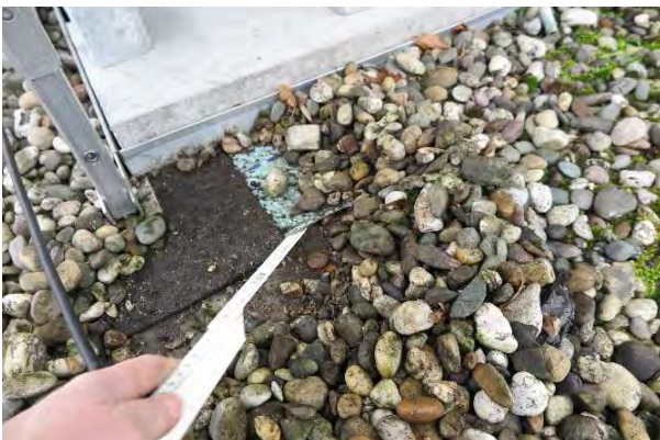
Abb. 93 Unter den Tragprofilen sind Bautenschutzmatte verlegt.
