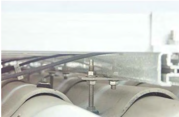
Abb. 68 Schraubverbindung durch die Wellplatteneindeckung in den Wellentälern
