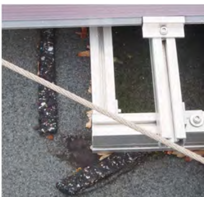
Abb. 46 Sehr geringe Breite der Bautenschutzmatte [Quelle: www.dgs-berlin.de ]
