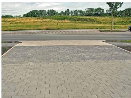
Abb. 6 a+b: Verfärbung von Steinoberflächen durch den Eintrag von Fugenmaterial
