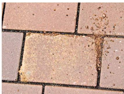
Abb. 14: Massiv zermürbte Pflastersteinkanten
