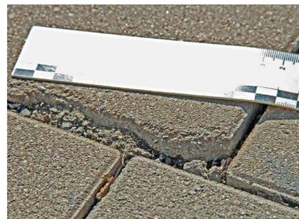
Abb. 8: Kantenschäden an einem Höhenversatz zwischen benachbarten Pflastersteinen
