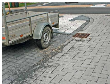
von Kantenschäden an befahrenen Flächen sollte der Planer zumindest bei höher beanspruchten Flächenbefestigungen die Verlegung im Fischgrät- oder Ellbogenverband wählen [5].
