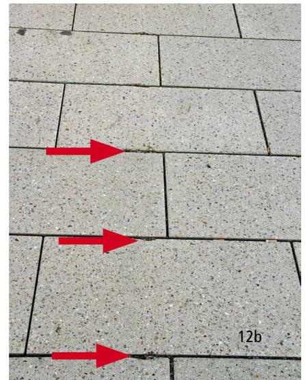
Abb. 12 a+b: Zwischenlagerung von Schuttcontainern auf der Flächenbefestigung
