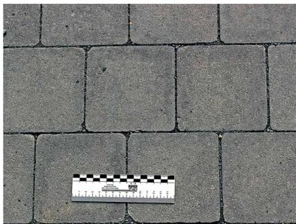
Abb. 10 a+b: Kantenschäden durch Verwendung einer Rüttelplatte ohne Plattengleitvorrichtung
