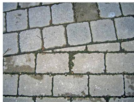
Abb. 7: fehlerhafter Zuschnitt von Pflastersteinen
