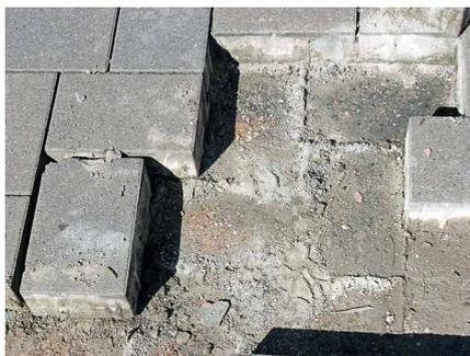
Abb. 5 a+b: »Abdichtung« der Bettung durch Verwendung kalksteinhaltiger Splitte
