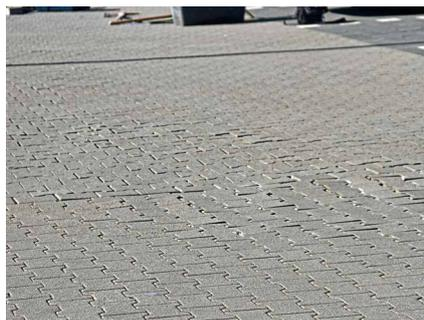
Abb. 4 a+b: Horizontalverschiebung der Pflastersteine sowie damit verbundene Kantenschäden
