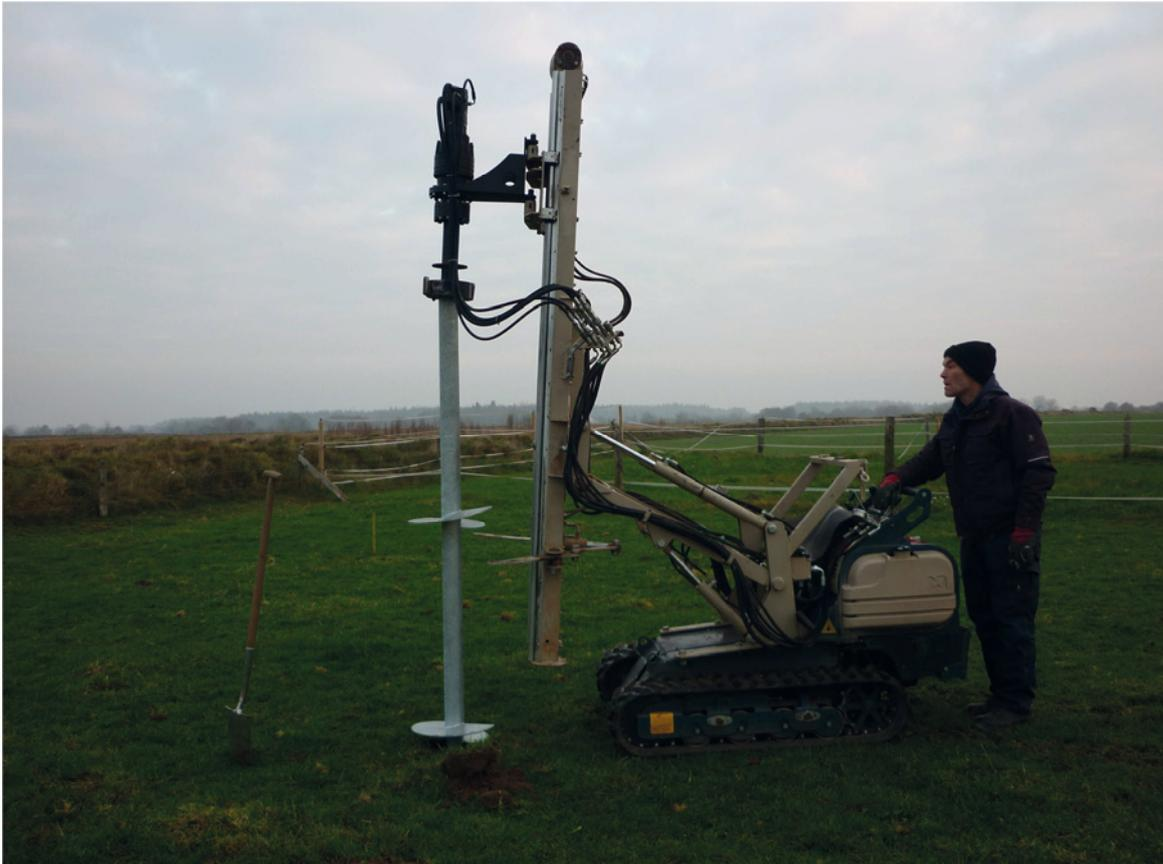
**Abb. 3:** Einbringen eines Schraubfundaments mit Kleinbohrgerät
