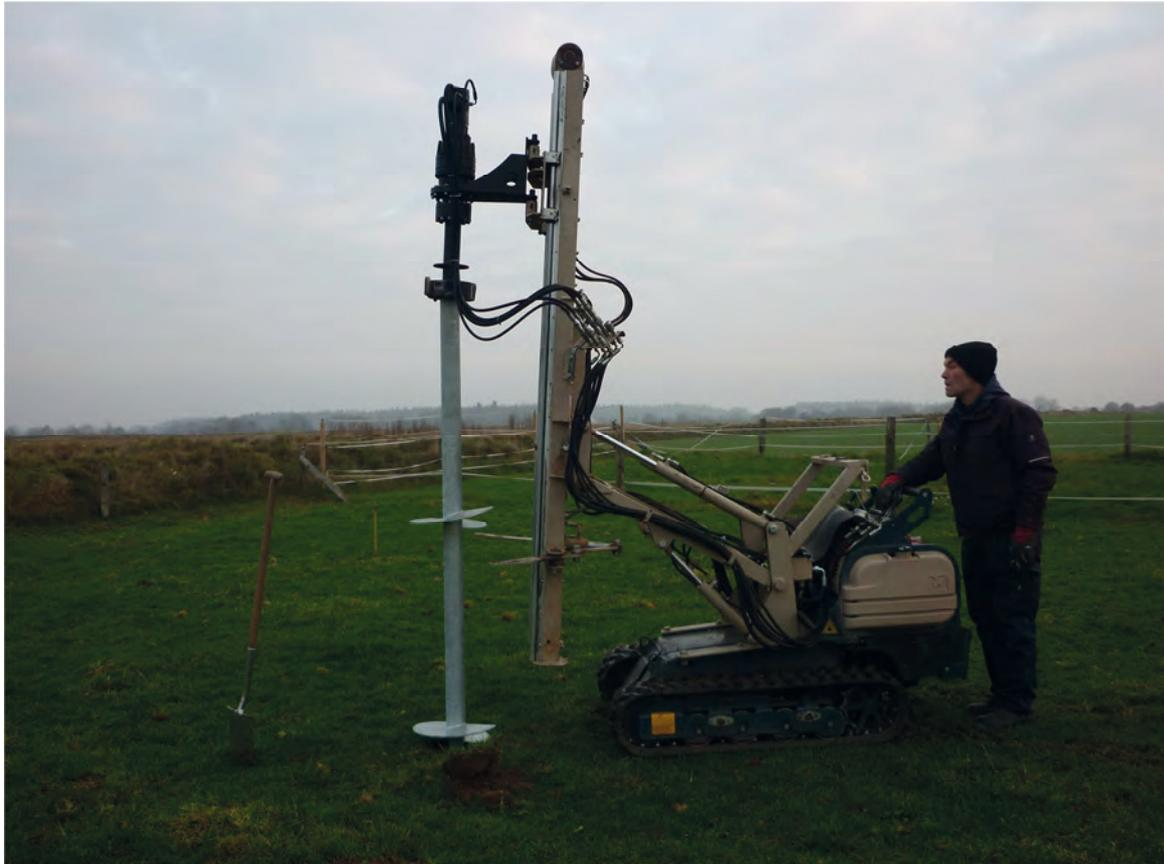
**Abb. 3:** Einbringen des Schraubfundaments mit Kleinbohrgerät
