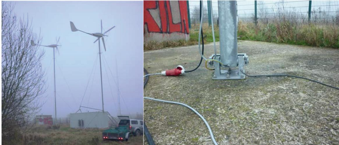
**Abb. 4:** links: Standort der Versuchsanlage (linke Anlage); rechts: Gründung des Turms auf vorhandenem Betonfundament
