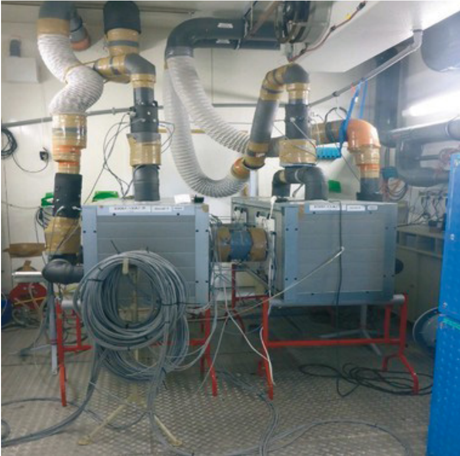
Prüfaufbau der Boxen in Prüfstelle 2
