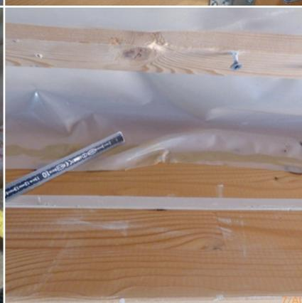
Primäre Leckage an einem Schnitt in der Folie im 2. Dachgeschoss mit dahinter sichtbarer Verfärbung der Mineralwolle-dämmung (Bild links). Sekundäre Leckage an einer Fuge im bodennahen Bereich der Gipskartonbekleidung im 2. Dachgeschoss (Bild rechts).
