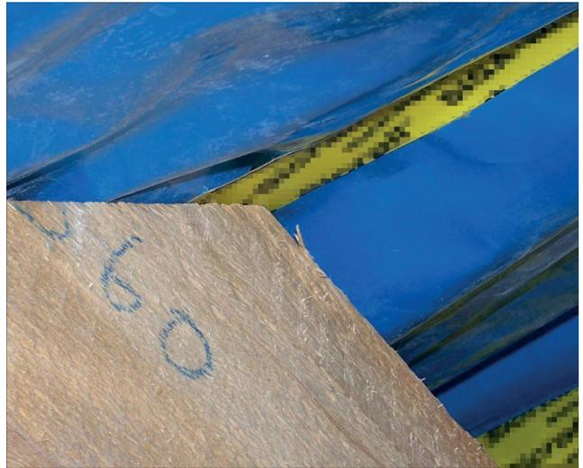
Bild 3.14b: Typische Fehlstellen in der Folienverklebung
