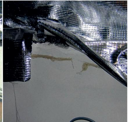
Die Ablaufspuren liegen sowohl zwischen Folie der Dachschräge und der Wand (Bild links) als auch auf der Folie der Dachschräge vor. Die Ablaufspuren auf der Folie sind in Verbindung mit Lecks an den Verklebungen der Folienüberlappungen und Durchdringungen der Abhänger zu bringen (Bild rechts: A, B).
