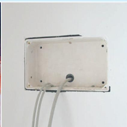
sekundäre Leckagen im Bereich einer Elektroinstallation einer Zwischenwand
