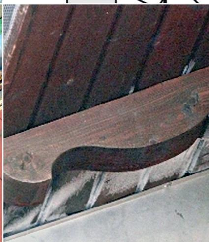
Tabelle 4.31: Verfärbungen einer Mineralwolledämmung und Schimmel auf der Unterseite einer Unterspannbahn
