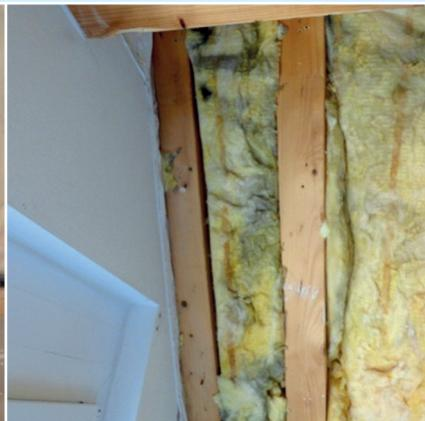
Lokal treten Verfärbungen auf der Innenseite der Dachbahn auf, die auf Schimmelpilze zurückzuführen sind (Bild links). Auf der Oberseite der Mittelpfette zwischen 1. und 2. Dachgeschoss (Niveau Boden 2. DG) sind z. T. Lecks im Anschlussbereich Folie der Dachschräge auf Mittelpfette vorhanden (hier: Einsatz einer pastösen Masse – Bild rechts). Diese Lecks befinden sich z. T. in deutlichem Abstand zu Verfärbungen in der Mineralwolle-dämmung.
