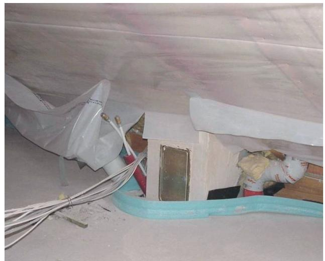
Bild 3.18: Offene Anschlüsse im Bereich von Durchführungen
