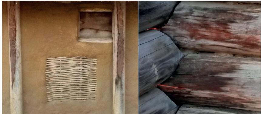
Bild 1.1: Mögliche frühzeitliche Bemühungen im Umgang mit Fehlstellen in der Gebäudehülle, dargestellt an Gebäuden im Pfahlbaumuseum Unteruhldingen/Bodensee, Bild links: Lehmputz auf „Leichtbauwand“, Bild rechts: ausgestopfte Fuge zwischen Hölzern
