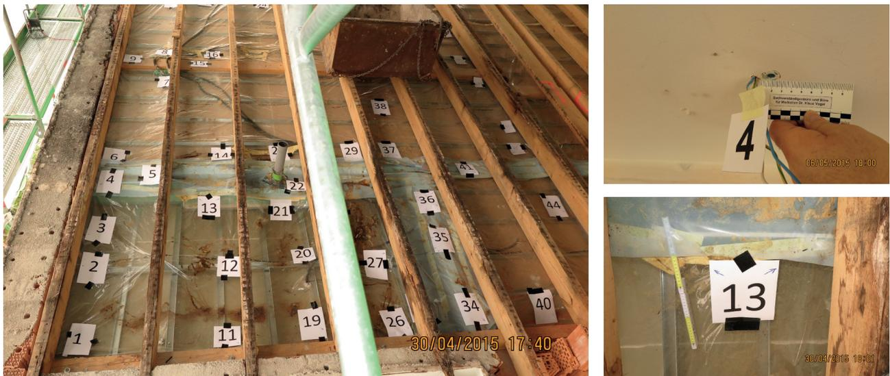
Bild 5.13: Dokumentation der Leckagen (links: Blick von außen auf Nummerierung der Leckagen in der Dampfbremse, oben rechts: Blick von innen auf eine Leckage in der Gipskartonbekleidung, unten rechts: Blick von außen auf eine Leckage im Bereich des Schachtes an einer Folienüberlappung)
