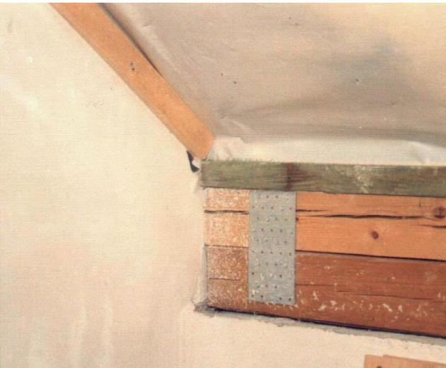
Bild 3.15: Anschluss der Luftdichtheitsschicht auf der Fußpfette – nicht auf dem Mauerwerk
