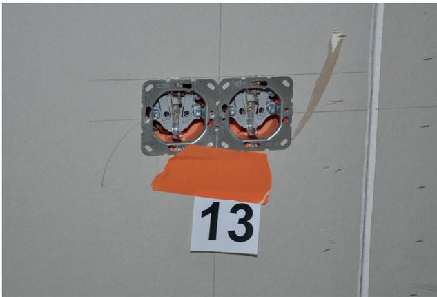
Bild 1.13: Steckdosen in einer Außenwand in Holzbauweise im 1. Obergeschoss. Der Volumenstrom durch die Leckage bei 50 Pa, ca. 1 m³/h, war den TeilnehmerInnen nicht bekannt (FLiB 2015)
