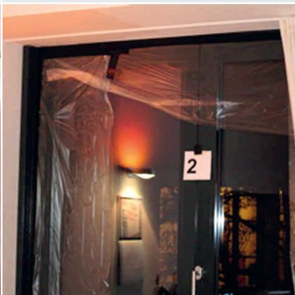
zum rechten Thermogramm gehörende Echtfarbenaufnahme von einer Fenstertür mit Sturz; zur räumlichen Auflösung von Luftströmungen ist die Fuge zw. Flügel und Blendrahmen mit einer infrarotdurch- lässigen Folie überklebt
