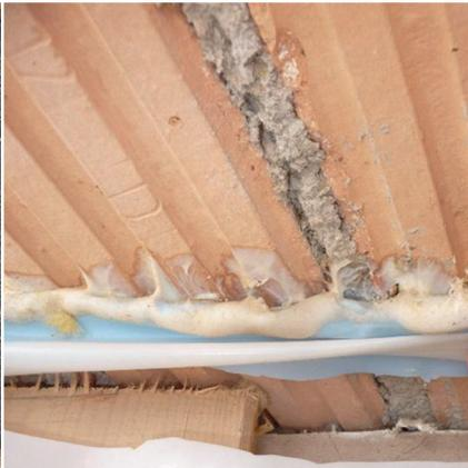
Luftdichtheitsschicht an unverputztes Mauerwerk angeschlossen (primäre Leckage)
