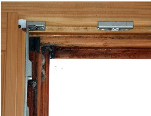
Bild 8.5: Tauwasser- und Schimmelpilzbildung im Falz des Stulpbereiches eines 2-flg. Holzfensters als Folge der Durchströmung der Konstruktion, da die Wirkung der Dichtebene 1 nicht gegeben ist
