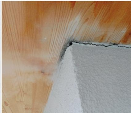
Tabelle 4.28: Verfärbungen mit Pilzbefall in einer Dachkonstruktion
