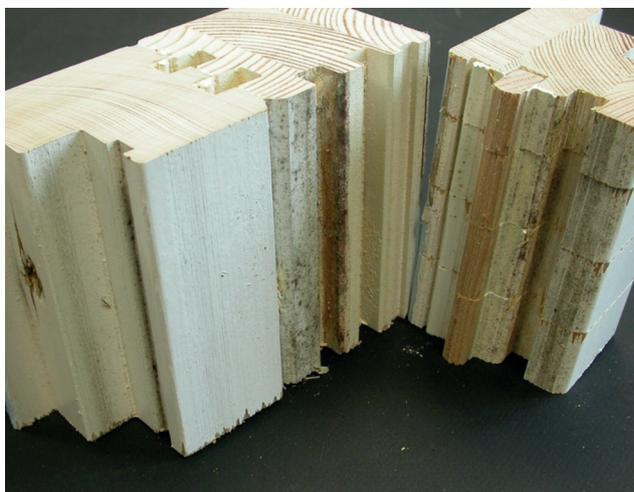
Bild 8.3: Geöffnete Fensterkonstruktion mit erkennbarer Schimmelpilzbildung an den von der Raumseite offenen Konstruktionsfugen
