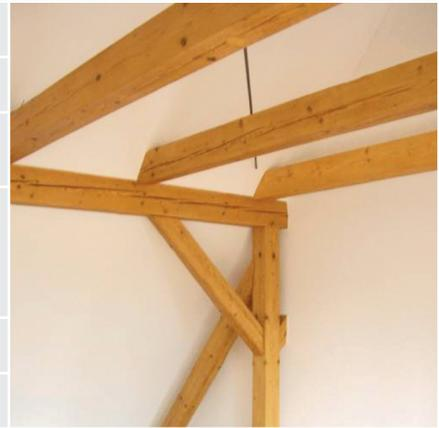
Durchdringungspunkte der Luftdichtheits- schicht bei innen sichtbarer Tragkonstruk- tion des Daches
