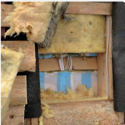
Fehlstellen in der Luftdichtheitsschicht im Bereich von Kabeldurchführungen (primäre Leckagen)
