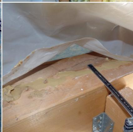
Auf der Oberseite der Mittelpfette zwischen 1. und 2. Dachgeschoss (Niveau Boden 2. DG) sind Lecks im Anschlussbereich Folie der Dachschräge auf Mittelpfette vorhanden (hier: Verlängerung der Folie mit Folienstreifen und Einsatz von Haftklebeband – Bild links). Im Anschlussbereich Folie der Dachschräge auf Firstpfette gibt es zahlreiche Fehlstellen, beispielsweise an nicht mit Klebmasse verfüllten Folienfalten (Bild rechts).
