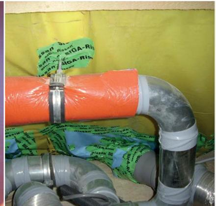
Versorgungsleitungen durchdringen in Bodennähe (traufseitig) die Folie der Luftdichtheitsebene; Leckagen aufgrund fehlender Deckeneinbindung und fehlerhafter Anschlüsse an die Rohrleitungen (primäre und sekundäre Leckagen)
