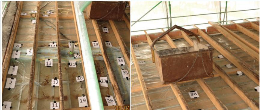
Beispiele für primäre Leckagen oberhalb des Bades; Beschädigungen der Folie im Bereich mechanischer Befestigungen
