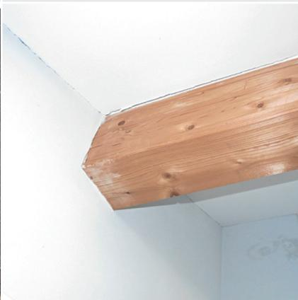
Abrisse der inneren Bekleidung im Bereich der Pfette (sekundäre Leckagen)
