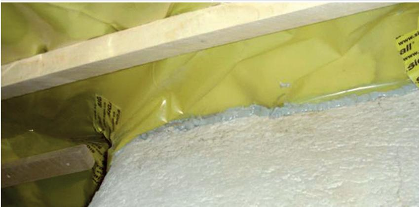
Fehlstellen in der Verklebung der Folie (zugleich Luftdichtheitsschicht) an den Kamin
