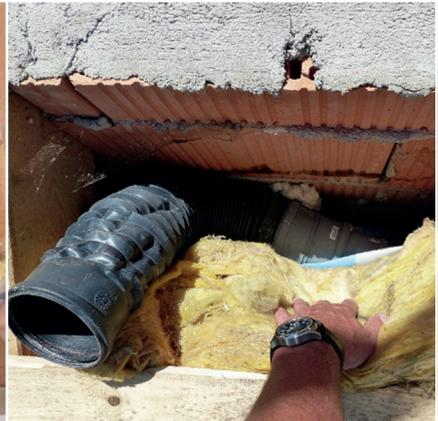
Fehlstellen in der Luftdichtheitsschicht, Öffnung zum Innenraum (primäre Leckage)
