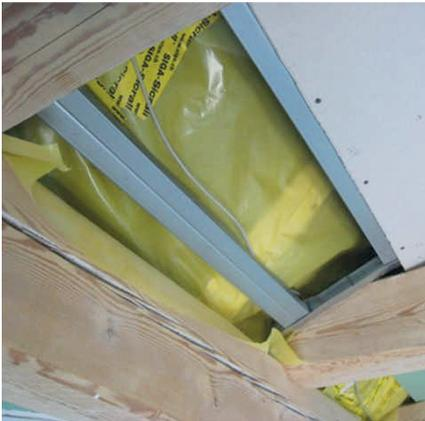
handwerklich nicht zu lösender Anschluss der Kehlbalken (mit Rissen) an die Luftdichtheitsebene (primäre Leckagen)
