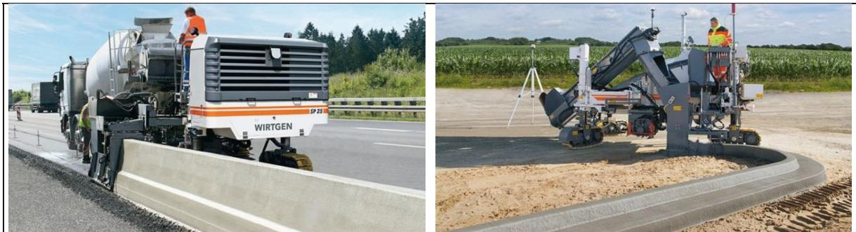
Abbildung 2.24: Gleitschalungsfertiger der Fa. Wirtgen im Einsatz [WIR16]
