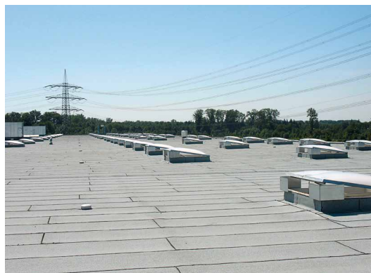
Abb. 1: Abdichtung nicht genutzter Dächer, Quelle VEDAG
