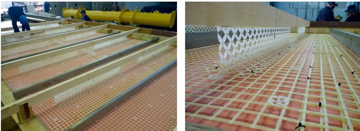
Abbildung 10: Bewehrung einer großformatigen Platte (links); Detail Übergreifungsstoß, Abstandhalter und Verbundgitter (rechts)
