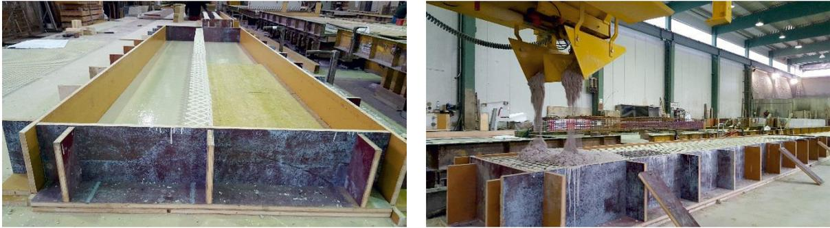
Abbildung 12: Einlegen der Dämmplatten (links: Mineralwolle); Betonage der oberen Deckschicht (rechts)
