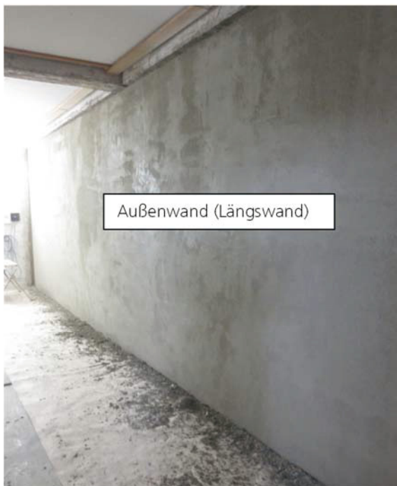
Bild 7: Fotos der Wände beim Auftragen des Putzes.
