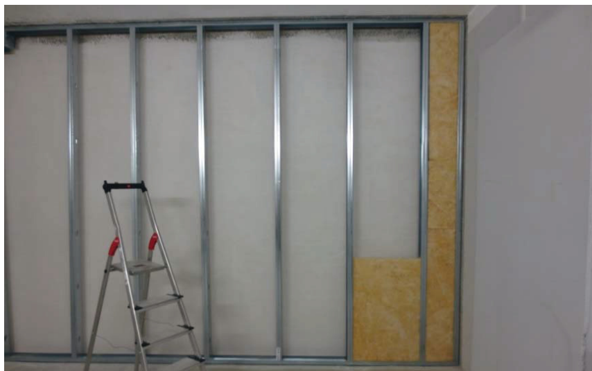
Bild 8: Foto der Vorsatzschale während der Montage.
