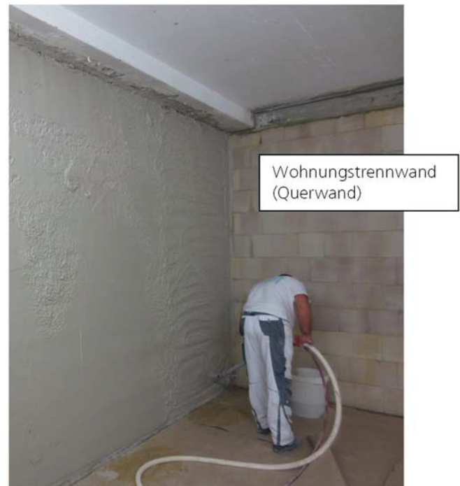
Bild 7: Fotos der Wände beim Auftragen des Putzes.
