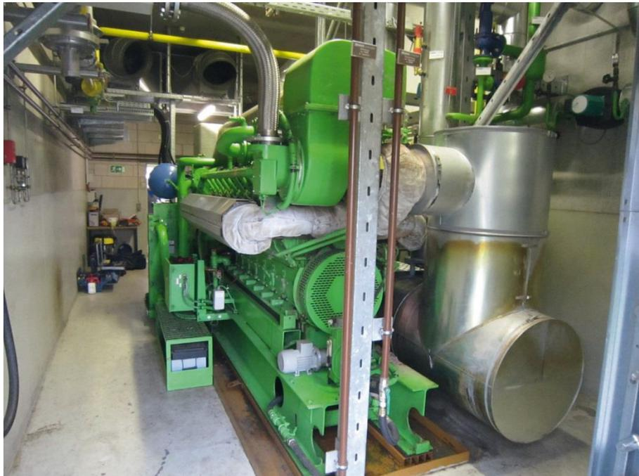
Abbildung 19: BHKW-Modul mit 825 kW<sub>el</sub> in BHKW-Anlage C
