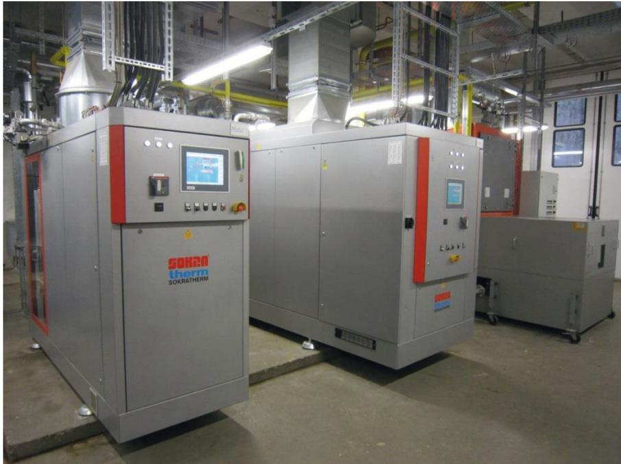
Abbildung 15: Gekapselte BHKW-Module in der BHKW-Anlage B
