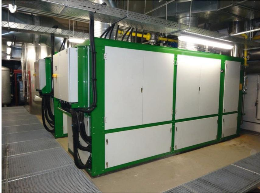
Abbildung 22: BHKW Module agenitor 406 (vorn) und avus 550plus (hinten) in BHKW-Anlage D
