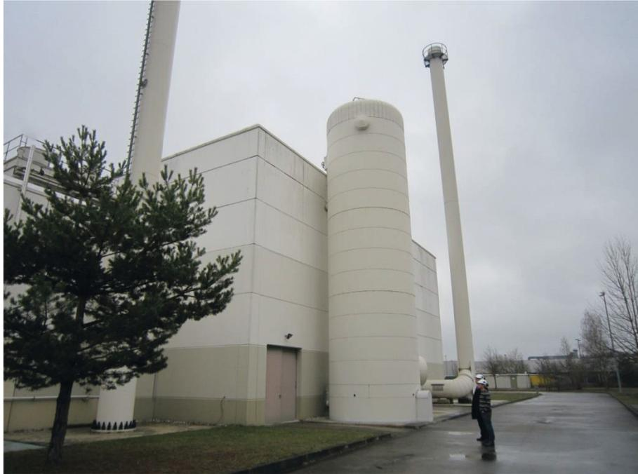
Abbildung 18: BHKW-Anlage C mit Kaminanlagen und Pufferspeicher 100 m<sup>3</sup>
