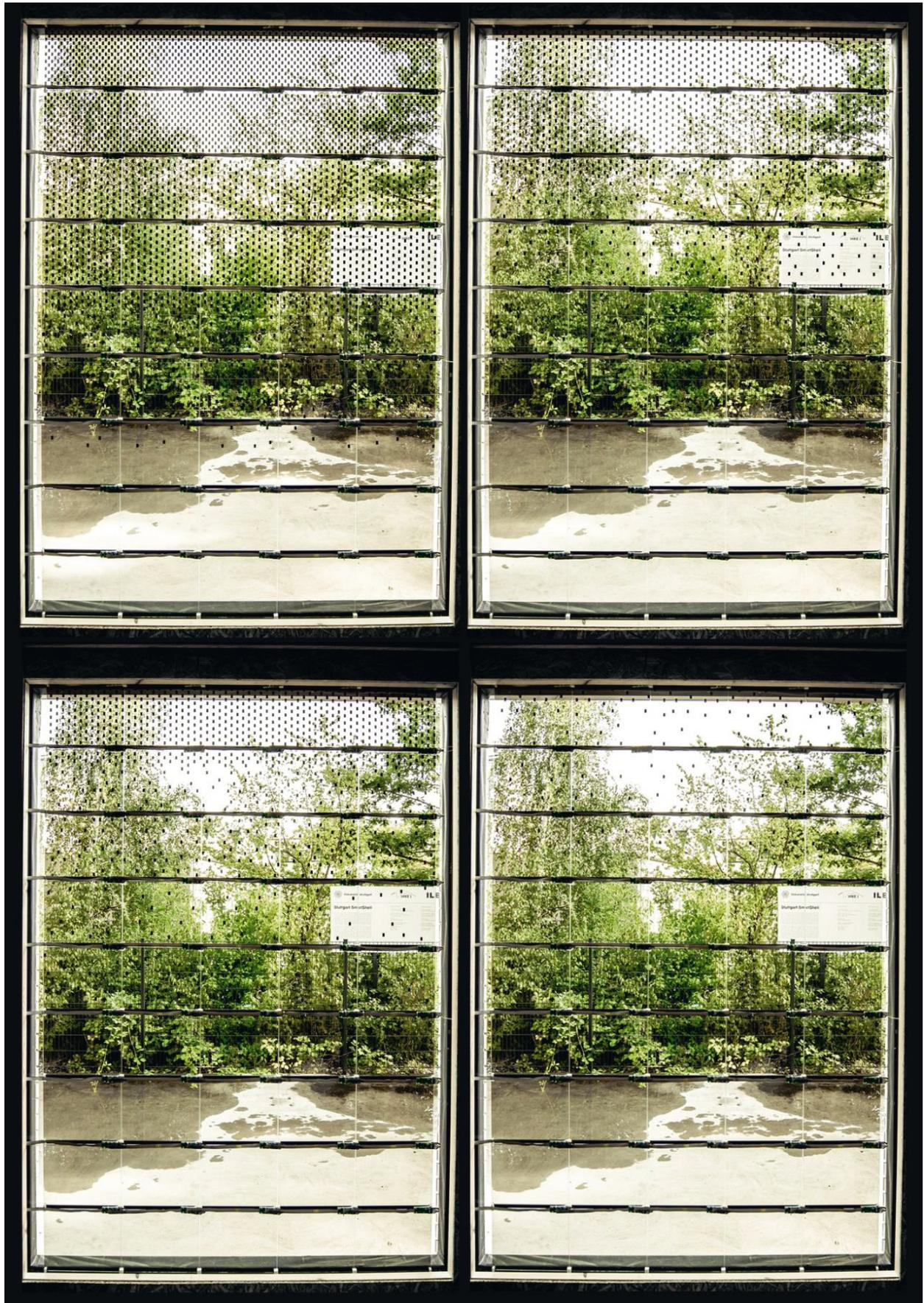
Abbildung 45: Die schaltbare Verglasung mit unterschiedlichen Abdunklungsmustern zur Steuerung des einfallenden Lichts (Foto: J. Rettig / ILEK)
