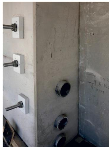
**Abbildung 64: Verstärkungsmaßnahmen an einer Hochstraße. (a) schematischer Aufbau, (b) Konsolblock an einer Stegaußenwand der Brücke inklusive Messspurmarkierung (Achse 9-3 Nord), (c) Übergangsbereich zwischen Konsole und Hohlkastenwand (Quelle: Fa. Hupfer Ingenieure)**
