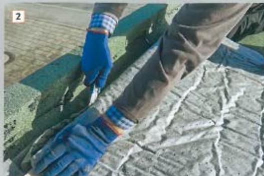
2 ... zurechtschneiden und vollflächig, stumpf gestoßen verlegen. Überlappung der Längsnähte schließen.
