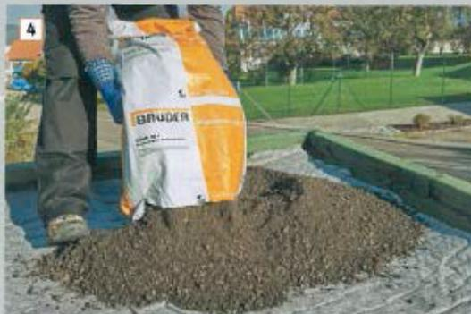
4 Unmittelbar im Anschluss pro Quadratmeter zwei Sack Pflanzerde einbauen. Bauder SDF-Matte nicht ohne Auflast liegen lassen.
