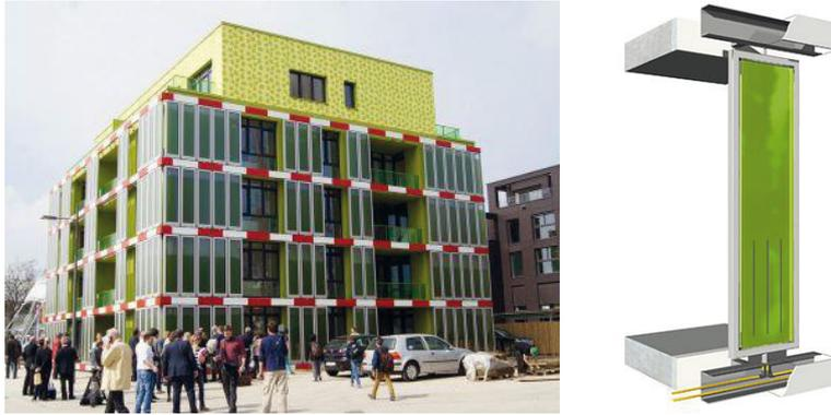
Abbildung 2-49: BIQ-Haus in Hamburg mit Bio-Reaktorfassade (rechts) und Fassadenelement (links) [76]
