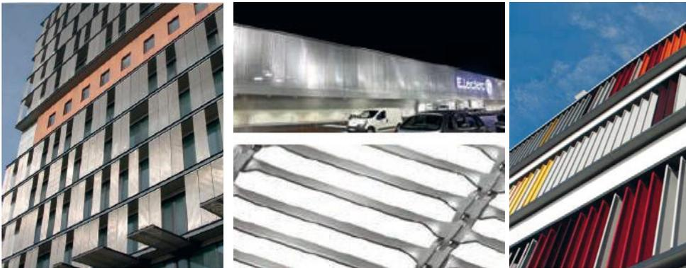
Abbildung 2-8: Starrer Sonnenschutz, links und Mitte: Architekturgewebe [20], rechts: feststehende Lamellen [21])
