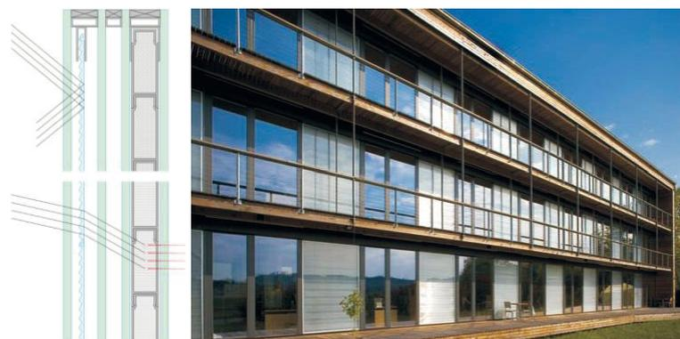
Abbildung 2-24: Verglasung mit PCM von GLASSX [31]
