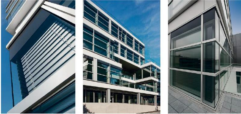
Abbildung 2-39: Closed cavity Fassade, Bilder aus [62]
