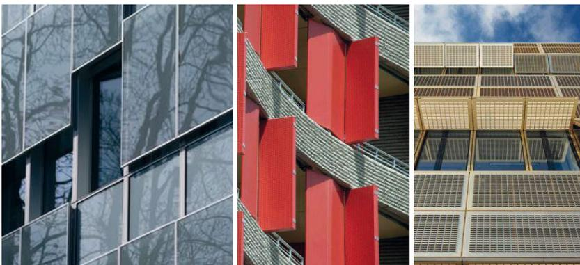
Abbildung 2-10: links: verschiebbares Sonnenschutzraster aus Streckmetall [25], Mitte: Faltläden [21], rechts: Klappläden [21]
