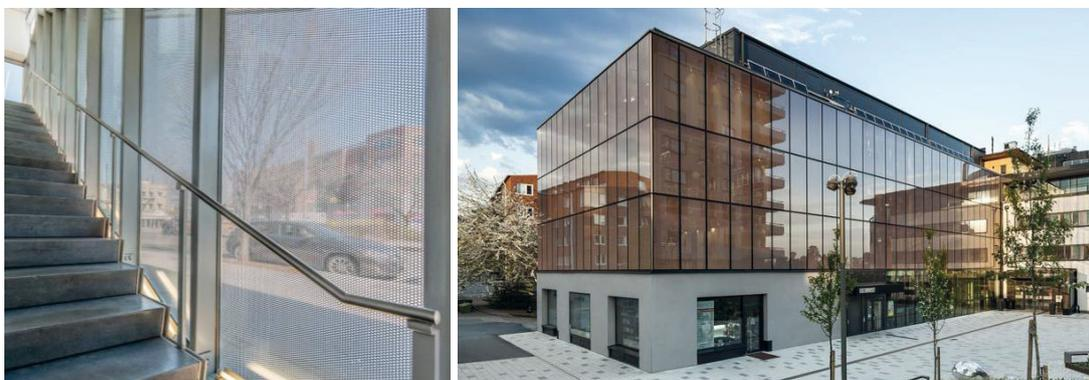
Abbildung 2-14: Sonnenschutzraster aus Metallgewebe (links) bzw. Streckmetall (rechts) von [30]
