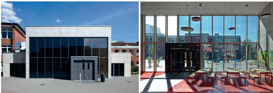
Abbildung 2-2: Elektrochrome Verglasungen von ECONTROL [9] im abgedunkelten Zustand
