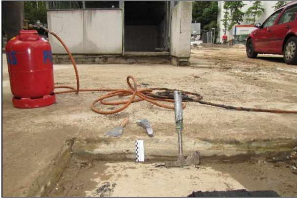
Bild 22 Schaumglasdämmung unter Abdichtung, die mit einem befahrbaren Schutzbeton abgedeckt ist.
