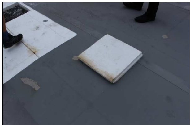
Bild 8 Zur Bestimmung des Feuchtegehalts und der Wärmeleitfähigkeit ausgebaute Dämmplatte aus EPS
