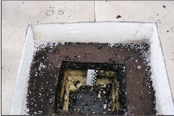
Bild 11 Öffnungsstelle in der Fläche mit stark durchfeuchteten PUR-Dämmstoffen
