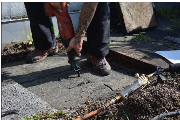
Bild 4 Dachabdichtung aus Bitumenbahnen unter Plattenbelag
