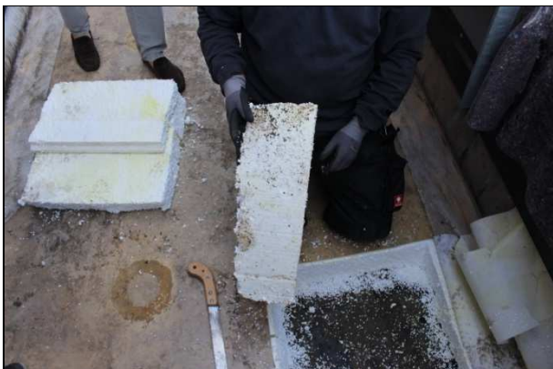
Bild 9 Zweilagig verlegte Dämmung aus EPS-Platten auf der Dachterrasse
