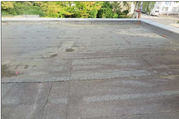
Bild 1 Dachfläche über Gewerbeeinheit
