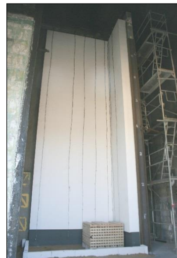
c) WDVS-Prüfkonstruktion nach Fertigstellung
