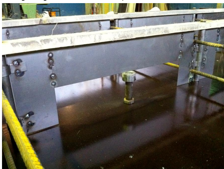
Abbildung 2 Positionierung des Kopfbolzens in der Schalung für Risskörper [10]
