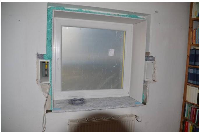
Einbau der Lüftungsgeräte und Innenleibung
