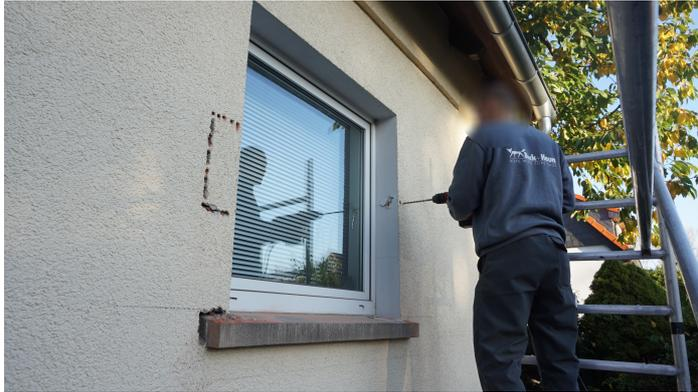
Bohrung durch der Wand für das Anbringen der dezentralen Lüftung
