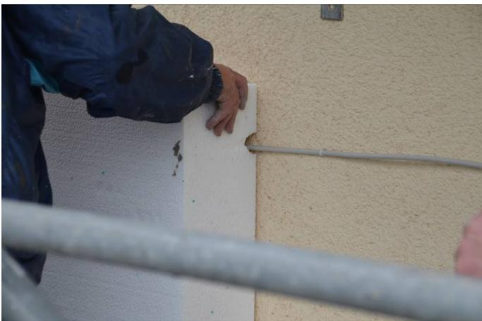
Anbringung des WDVS an die Wand (Stromverkabelung)
