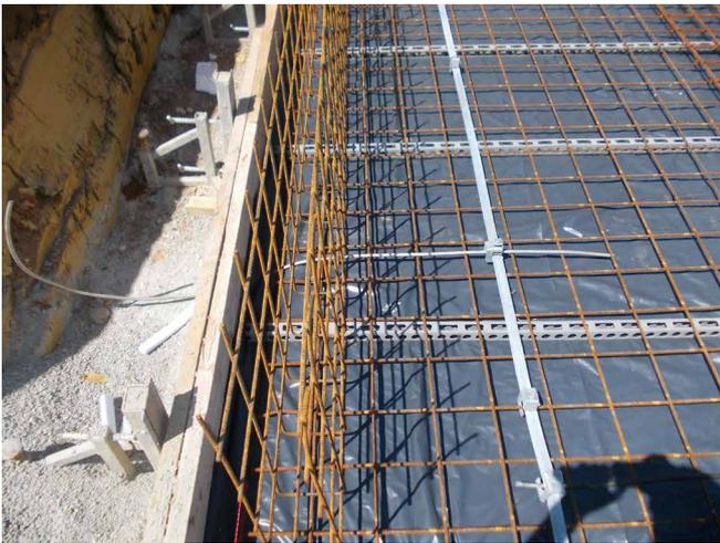
Abb. 7: Aufwändiger Fundamenterder: Funktionspotentialausgleich mit Bandstahl in der Bodenplatte mit V4A-Edelstahl Verbindungsteil für den äußeren erdfühiligen Ringerder
