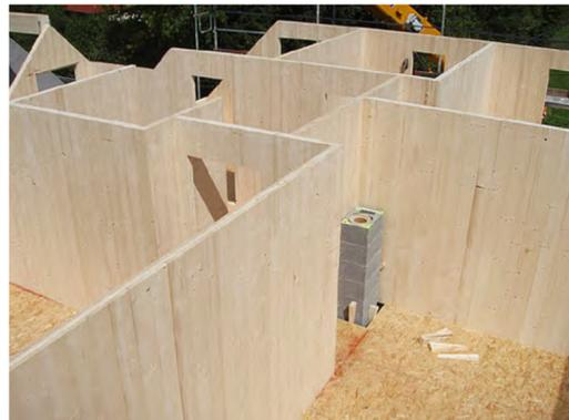
Abbildung 123: Wandtafeln aus Brettsperrholz eines Einfamilienhauses [23]
