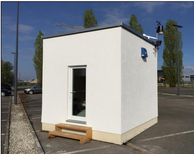
Abbildung 7: Errichteter Brettsperrholzkubus
