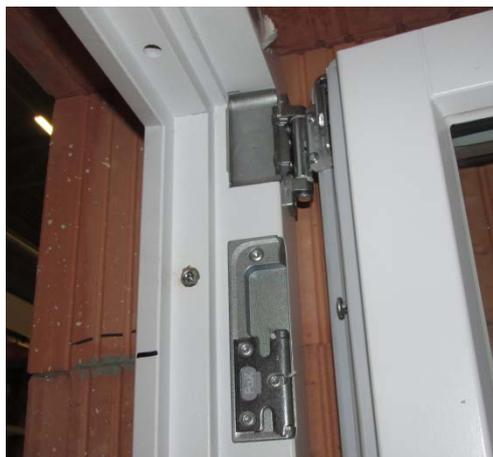
**Abbildung 2** Detail des Blendrahmenprofils des Profilsystems PaXpremium
