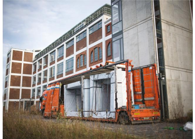
Abb. 32: Anlieferung der ersten vier Module auf einem Tieflader.
