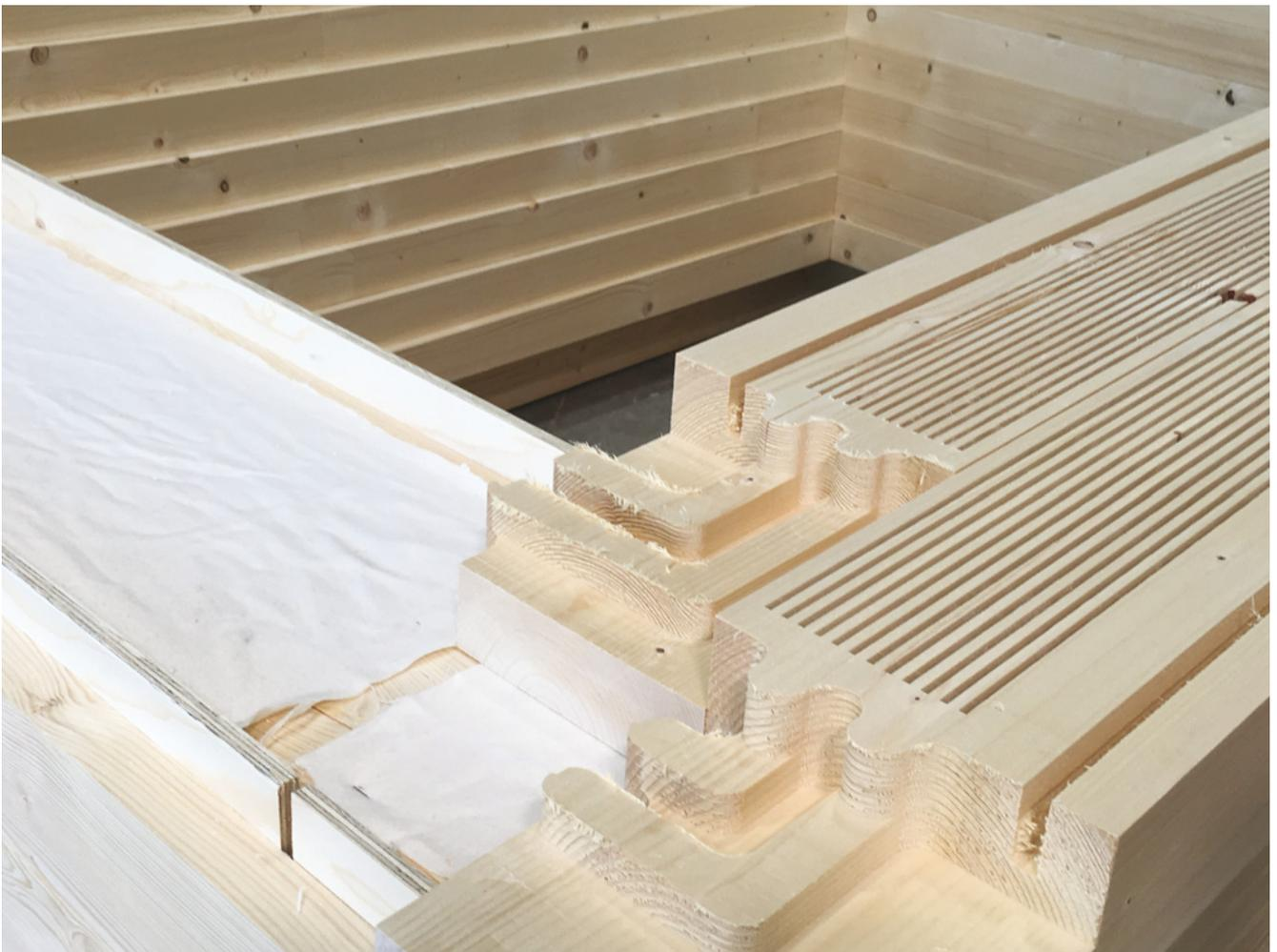
Abb. 28: Die einzelnen Module werden liegend zusammengebaut, um einen engen Verbund der Balken zu erleichtern. Zwischen den Balkenlagen werden Stoffe eingelegt, um die Luftdichtigkeit zu erhöhen.
