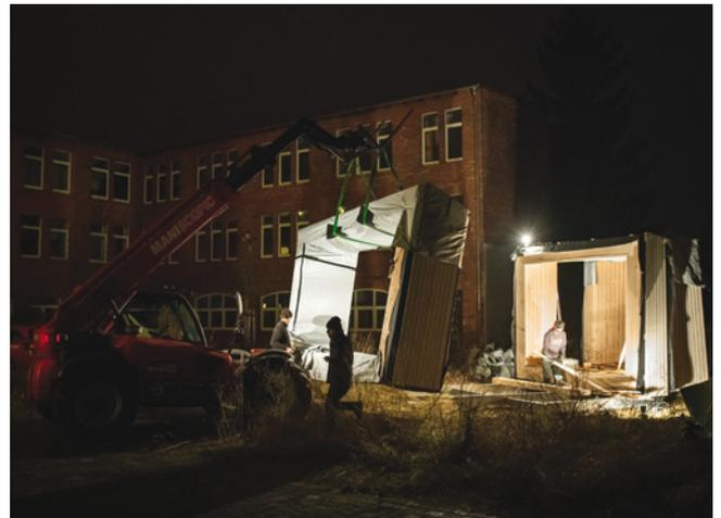
Abb. 34: Jedes Module wird mit einem Radlader auf dem Stahlrahmen abgesetzt.
