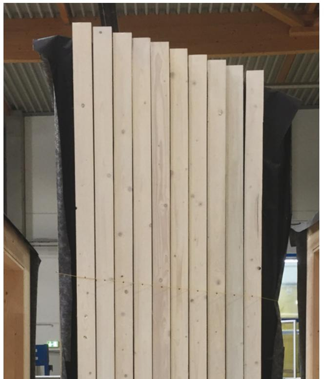
Abb. 31: Die schwarze Dachbahn (links) wird über die versetzten Balken der Primärkonstruktion gestülpt und mit Klammern befestigt. Die Konterklötze werden durch die Fassadenbahn fest verschraubt. Die weiß lasierten Fassadenplanken (rechts) haben 5mm Fugen zueinander und werden anschließend auf die Kötze von außen geschraubt.
