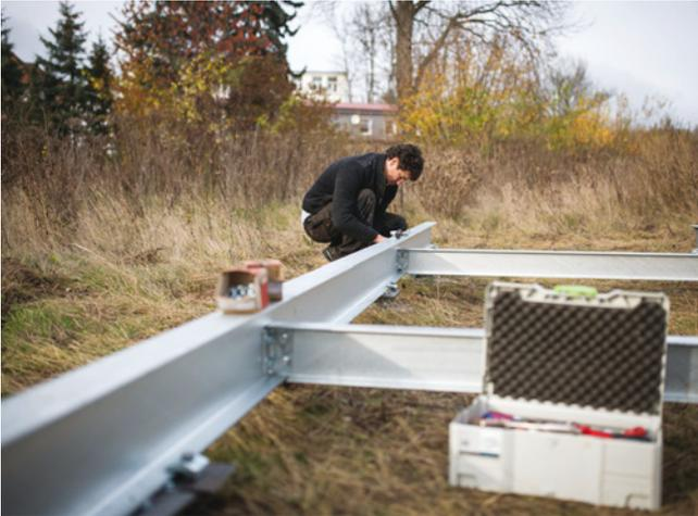
Abb. 31: Aufbau eines mit Schraubfundamenten befestigten Stahlrahmens als Unterkonstruktion.
