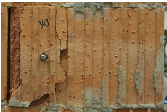
Abbildung 8-43: Versagensbild Stufentest PFZ T24 – 1 Steg Test 3
