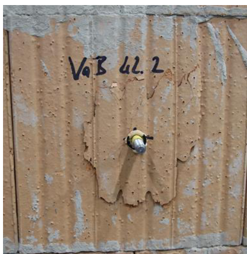
Abbildung 8-76: Versagensbild Bau T8 24 – 2 Stege – Test 2
