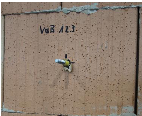
Abbildung 8-74: Versagensbild Bau Plan-T12 – viele Stege – Test 3
