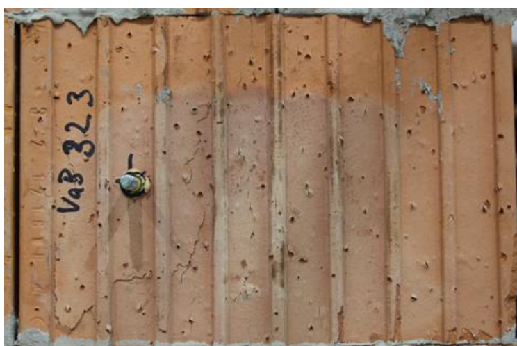
Abbildung 8-80: Versagensbild Bau PFZ-T24 – 1 Steg – Test 3
