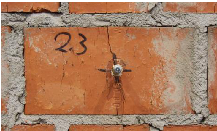
Abbildung 8-6: Versagensbild Ref Vollziegel – Mz-2DF, Läufer – Test 3
