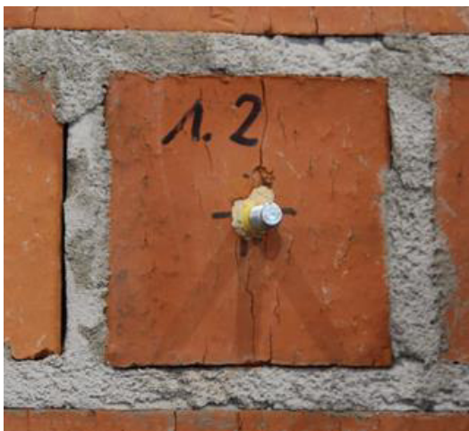
Abbildung 8-2: Versagensbild Ref Vollziegel – Mz-2DF, Binder – Test 2
