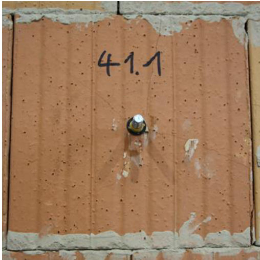
Abbildung 8-10: Versagensbild Ref T8 24 – 2 Stege – Test 1
