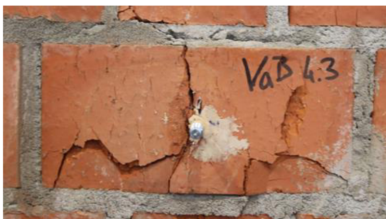
Abbildung 8-71: Versagensbild Bau Vollziegel – Mz-2DF, Läufer – Test 3
