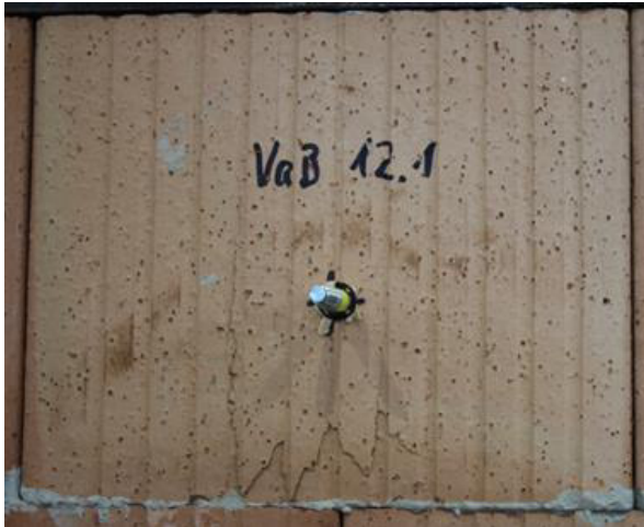
Abbildung 8-72: Versagensbild Bau Plan-T12 – viele Stege – Test 1
