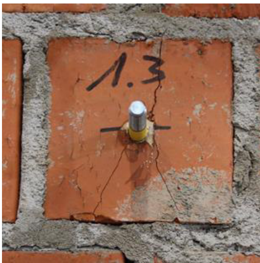
Abbildung 8-3: Versagensbild Ref Vollziegel – Mz-2DF, Binder – Test 3
