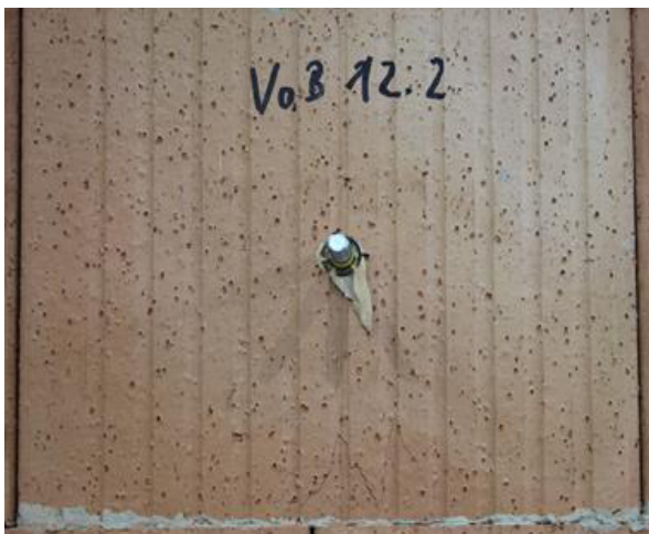
Abbildung 8-73: Versagensbild Bau Plan-T12 – viele Stege – Test 2
