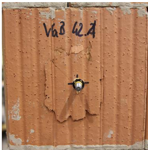
Abbildung 8-75: Versagensbild Bau T8 24 – 2 Stege – Test 1
