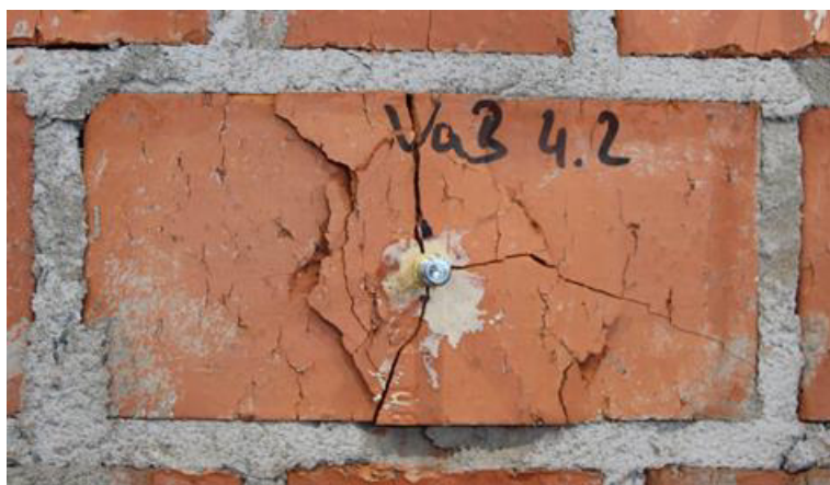
Abbildung 8-70: Versagensbild Bau Vollziegel – Mz-2DF, Läufer – Test 2
