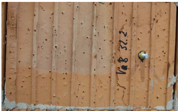
Abbildung 8-79: Versagensbild Bau PFZ-T24 – 1 Steg – Test 2
