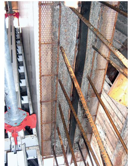
**Abb. 7:** Biegesteifer Anschluss einer Elementwand an eine Ortbetonwand
