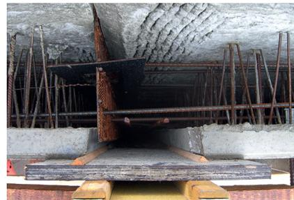
**Abb. 9:** Biegesteifer Stoß einer Elementwand
