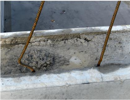
Abb. 28: Absetzen des Betons am Wandkopf
