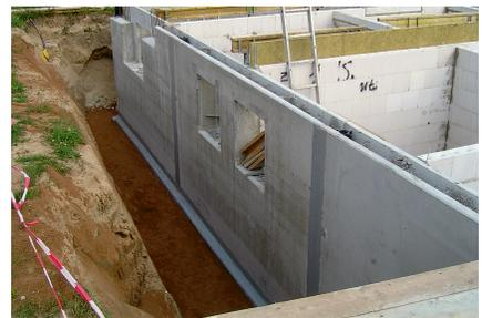
Abb. 18: Abdichtung von Arbeits- und Stoßfugen mit einem streifenförmigen, vollflächig aufgeklebten Fugenabdichtungssystem
