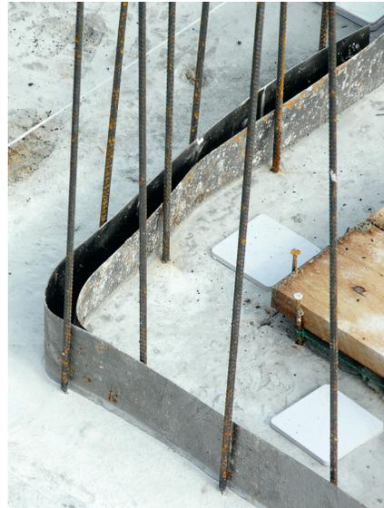
**Abb. 12:** Beispiel für einen nicht zulässigen Überlappungsstoß unbeschichteter Fugenbleche
