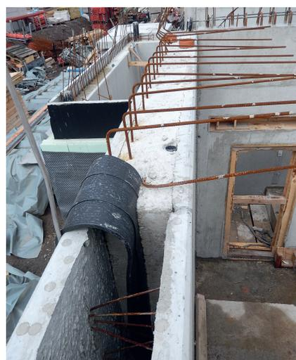
**Abb. 6:** Innenliegendes Arbeitsfugenband A 320 in die vertikale Arbeitsfuge bei einer Elementwand
