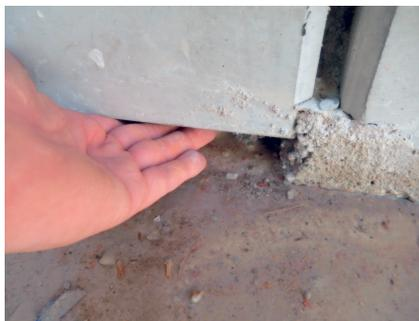
**Abb. 26:** Kiesnester und Gefügestörungen im Bereich des Sohle-Wand-Anschlusses einer Elementwand
