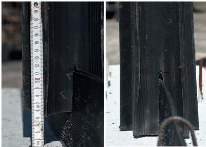
Abb. 15: Fachgerecht (links) und nicht fachgerecht (rechts) ausgeführter Fußpunkt beim Dichtrohr
