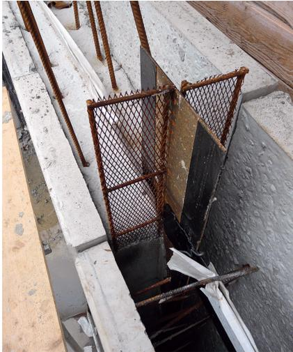
**Abb. 8:** Streckmetallabschalung mit integriertem beschichtetem Fugenblech zur Herstellung einer vertikalen, »abgedichteten« Arbeitsfuge im Elementwandstoß
