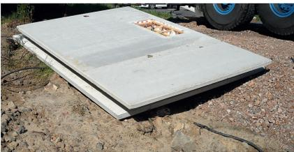
Abb. 20: Nicht fachgerechte Zwischenlagerung von Elementwänden
