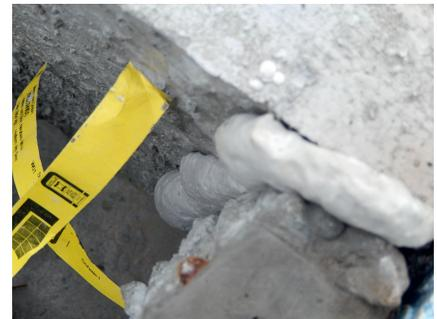
Abb. 23: Bauschaum, der unkontrolliert in den Zwischenraum der Elementwand eingedrungen ist und den Ortbetonquerschnitt reduziert
