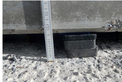
Abb. 21: Elementwände mit ausreichender (oben) und nicht ausreichender Aufständerhöhe (unten)
