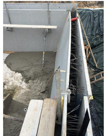
**Abb. 27:** Aufbrechen der Elementwand infolge zu großer Betoniergeschwindigkeit
