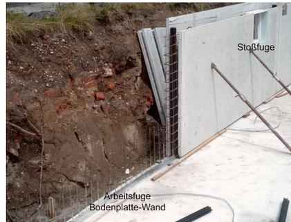
**Abb. 5:** Abdichtung der Elementwand mit Fugenband in der Arbeitsfuge Bodenplatte – Wand und einem Dichtrohr in der Stoßfuge
