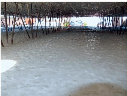
**Abb. 2:** Fertigteilplatten, bei denen die Anforderungen an die Rauigkeit erfüllt (oben) bzw. nicht erfüllt (unten) werden.
